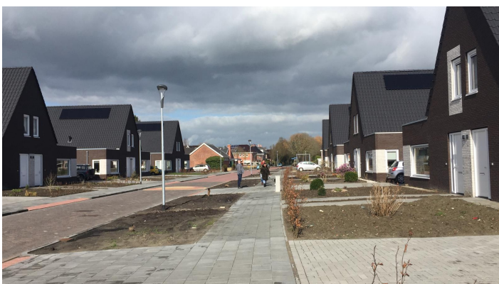
Fig.1: Nieuwbouw 28 aardbevingsbestendigere woningen aan de Klaas Bosstraat in Appingedam, Woongroep Marenland. Foto: Julia Finkielsztajn
