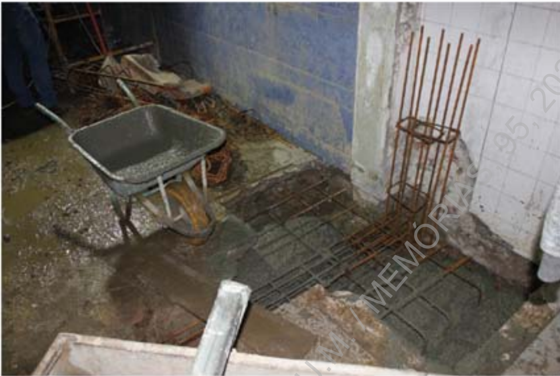
Foto 50 – Betonagem da sondagem 2.
