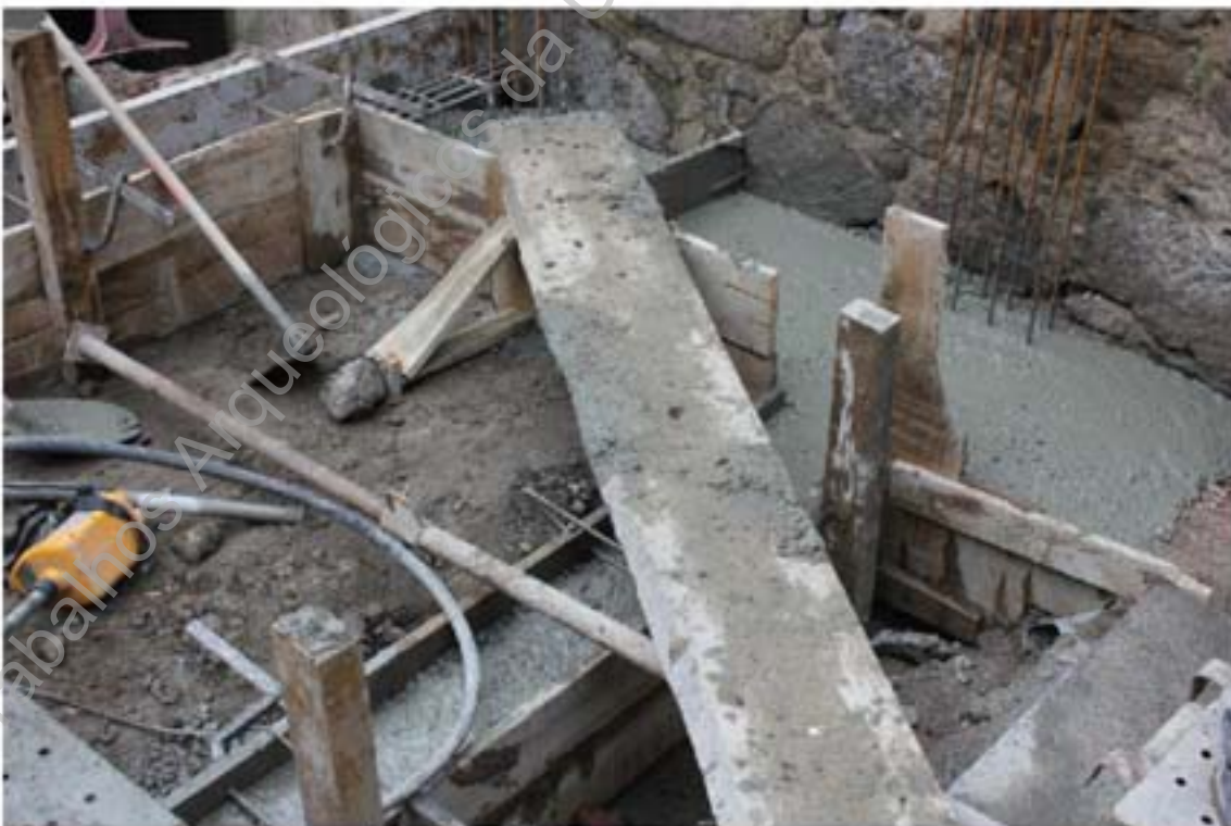
Foto 51 – Betonagem da sondagem 3.
