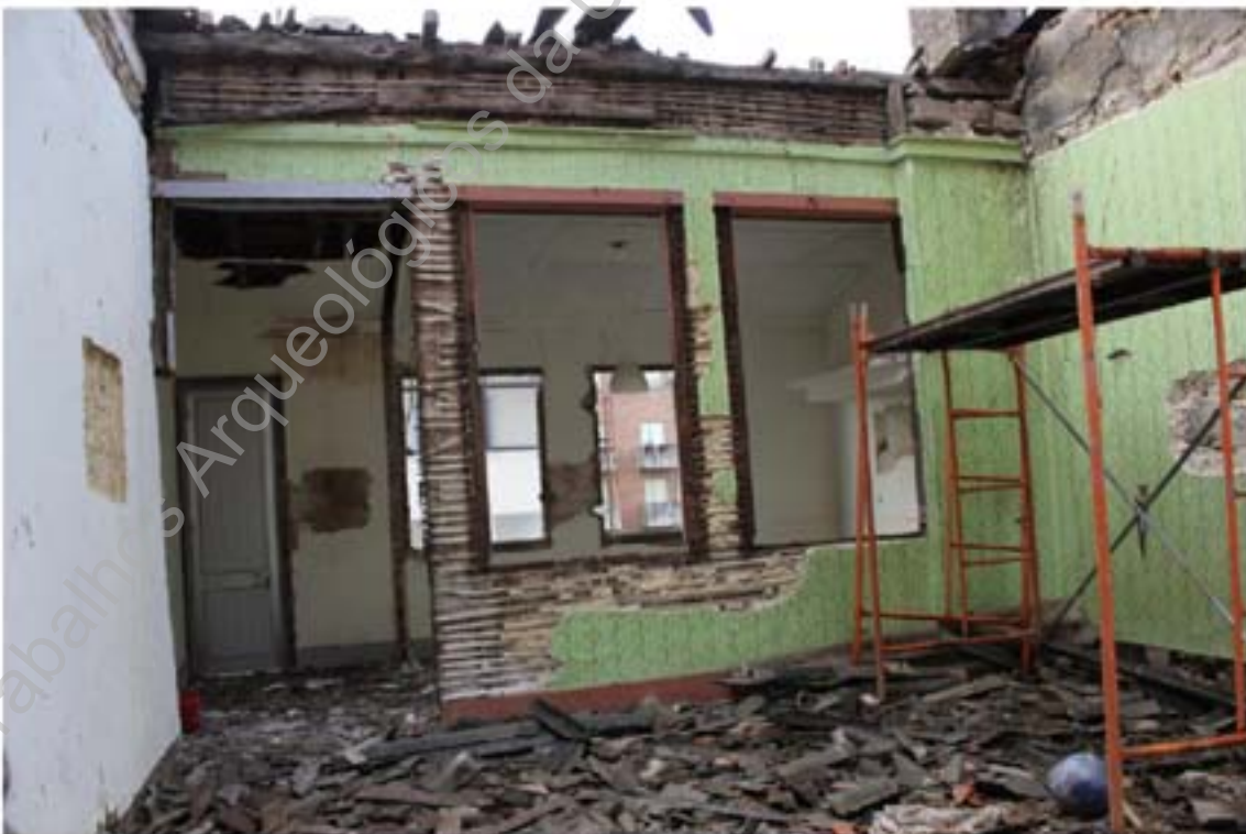
Foto 43 – Acompanhamento da demolição do edificado interno.
