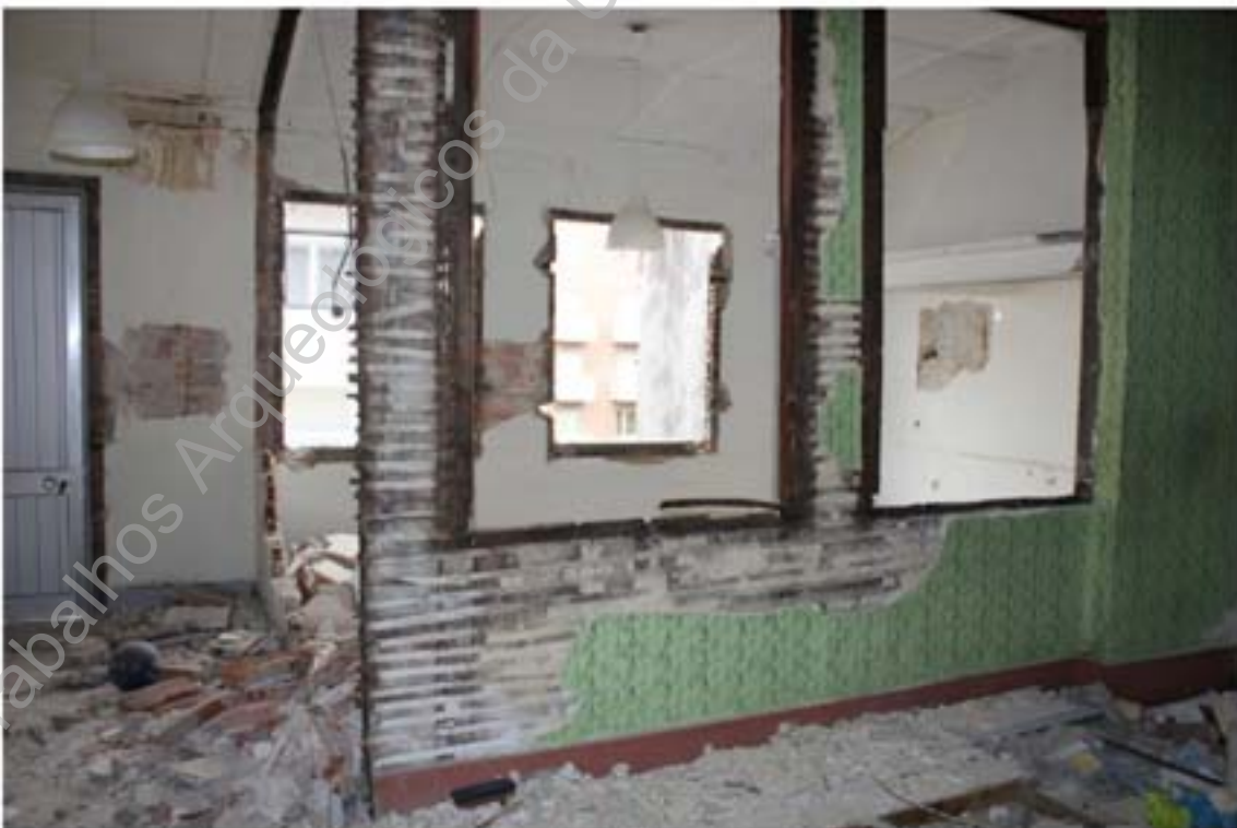
Foto 41 – Acompanhamento da demolição do edifício interno.
