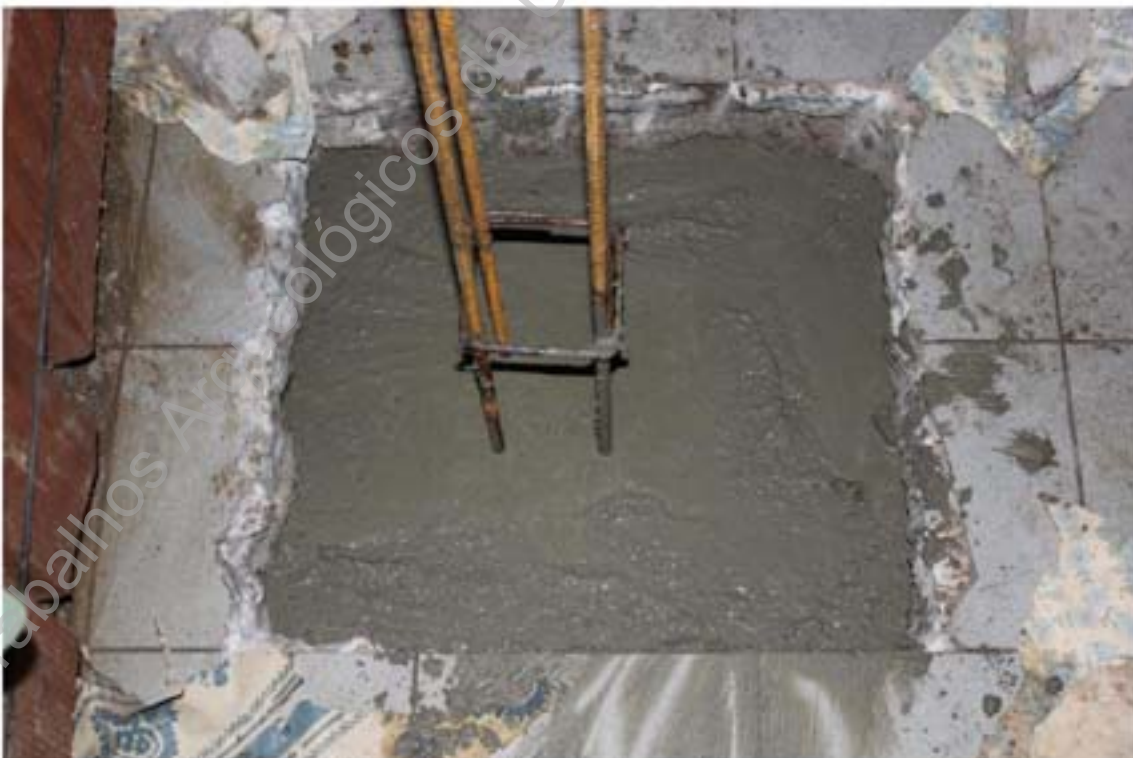
Foto 49 – Betonagem da sondagem 1.
