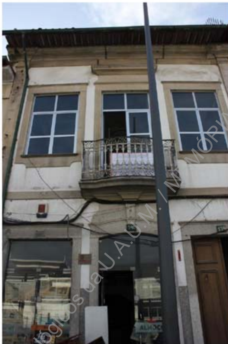
Foto 1 – Fachada do edifício localizado na Praça do Comércio nº 139-141.
