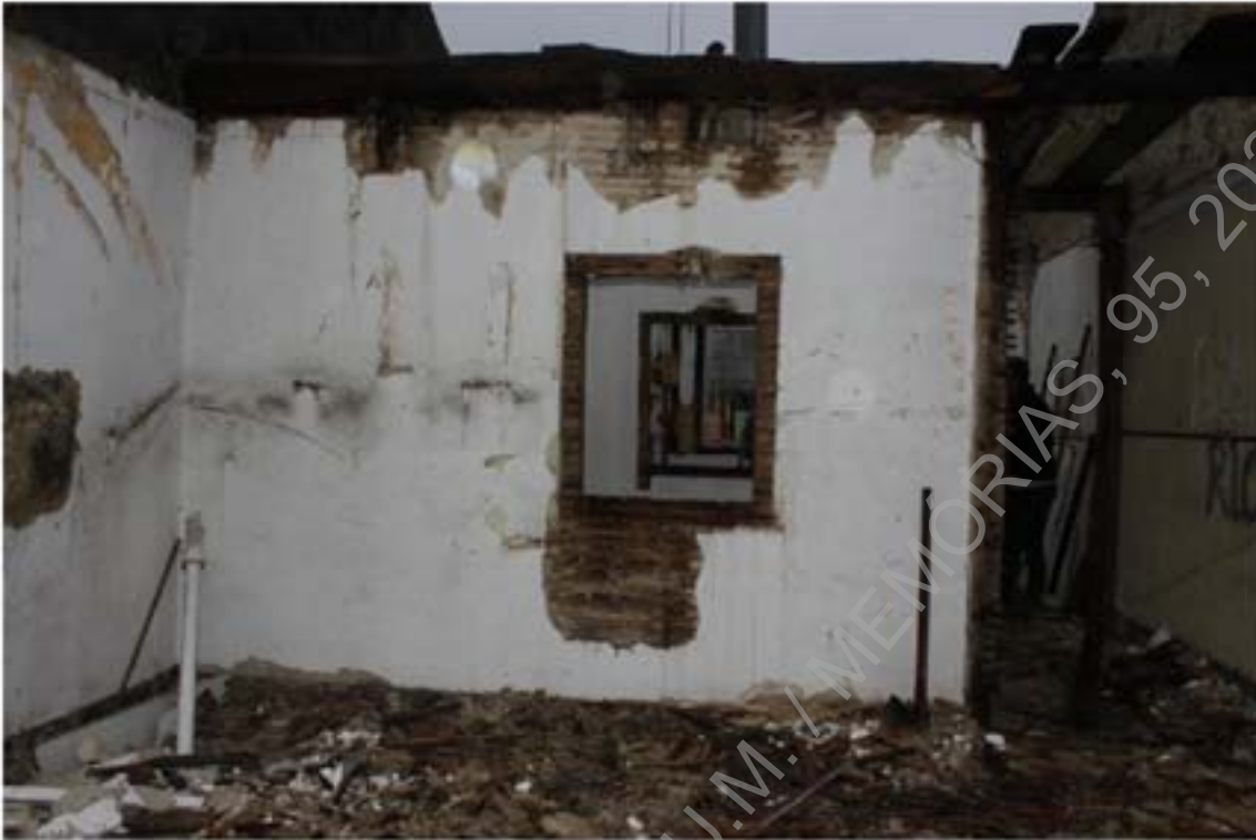
Foto 42 – Acompanhamento da demolição do edificado interno.
