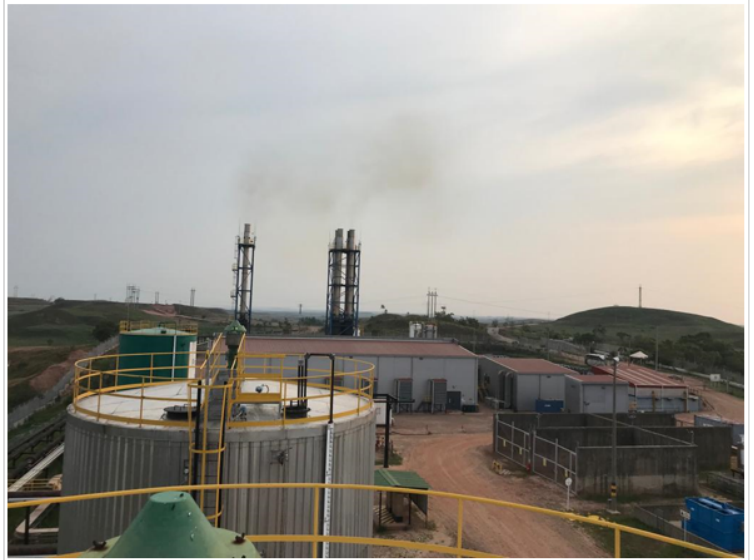
Grafico 5: Área de generación eléctrica de la planta de inyección
