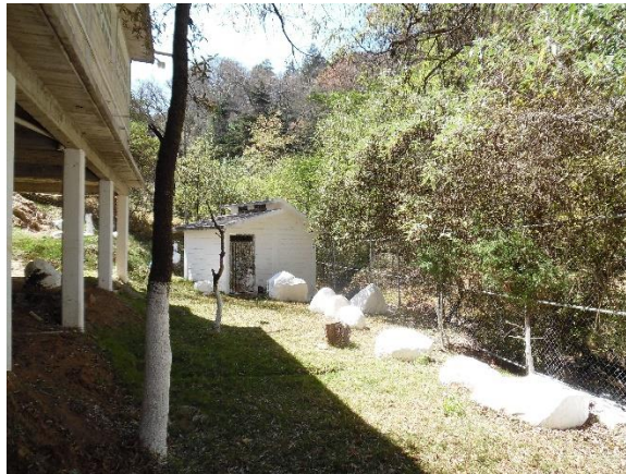
Figura 4.25. Zona de protección interna del manantial Agua Azul.
