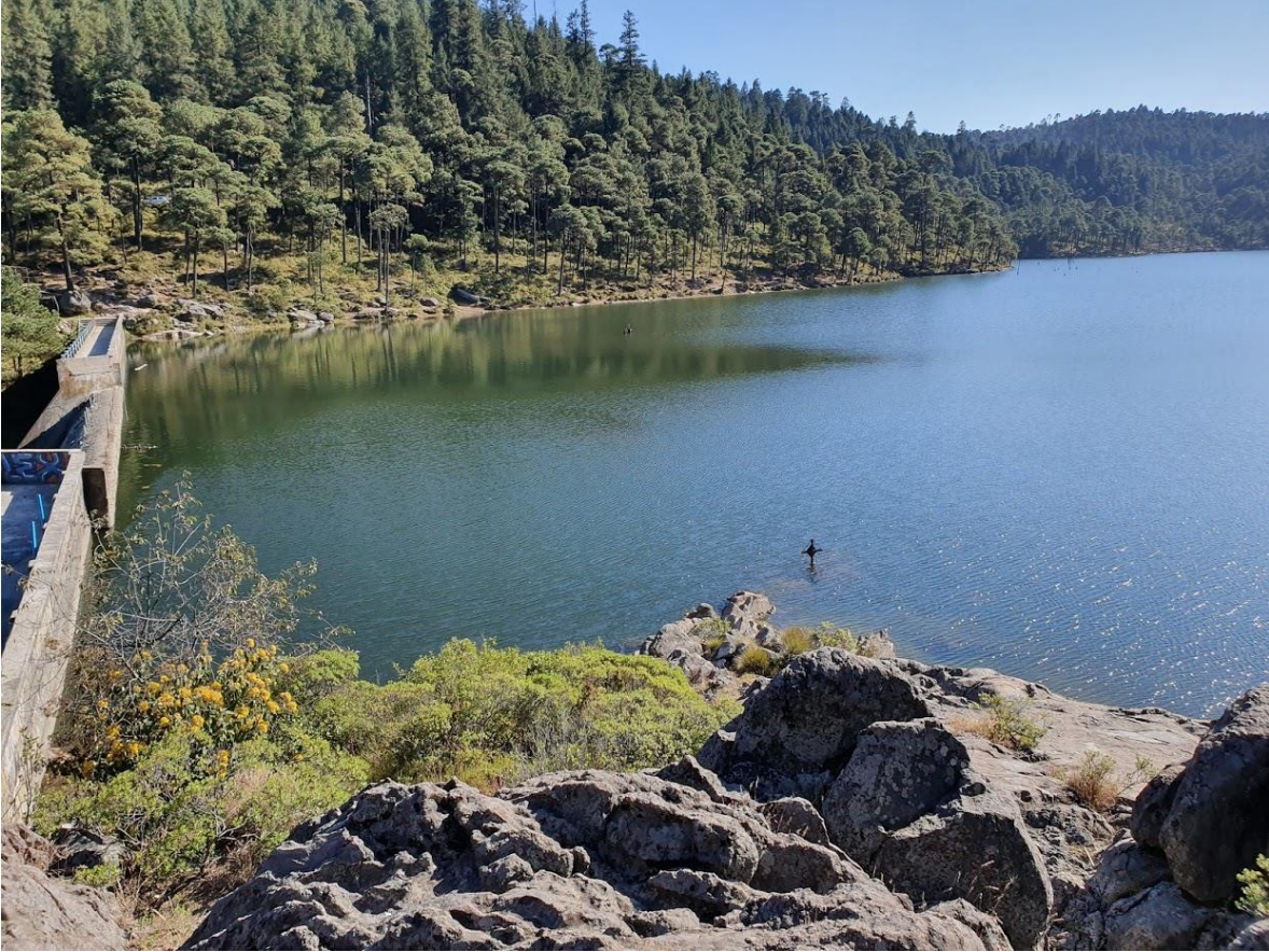
Figura 2.12. Presa Iturbide, Isidro Fabela, Estado de México.
