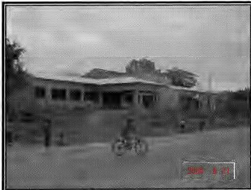
H.R.S.T. Remodelación que será la entrada principal del futuro ubicada en el costado norte la Institución y a dos cuadras de la carretera que une Tegucigalpa con San Pedro Sula. JUIJTER
