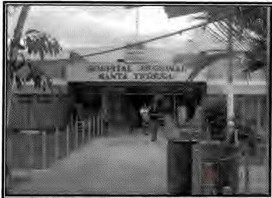
H.R.S.T. Entrada principal. Area administrativa. Costado Este. JUTER
