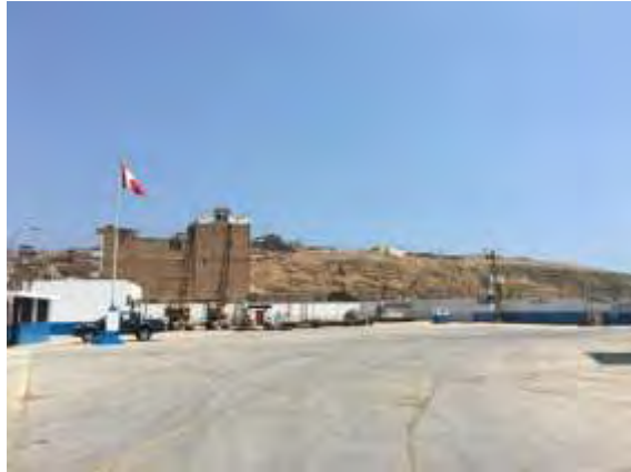
Figura 19. Instalaciones del Terminal Portuario Elaboración propia
