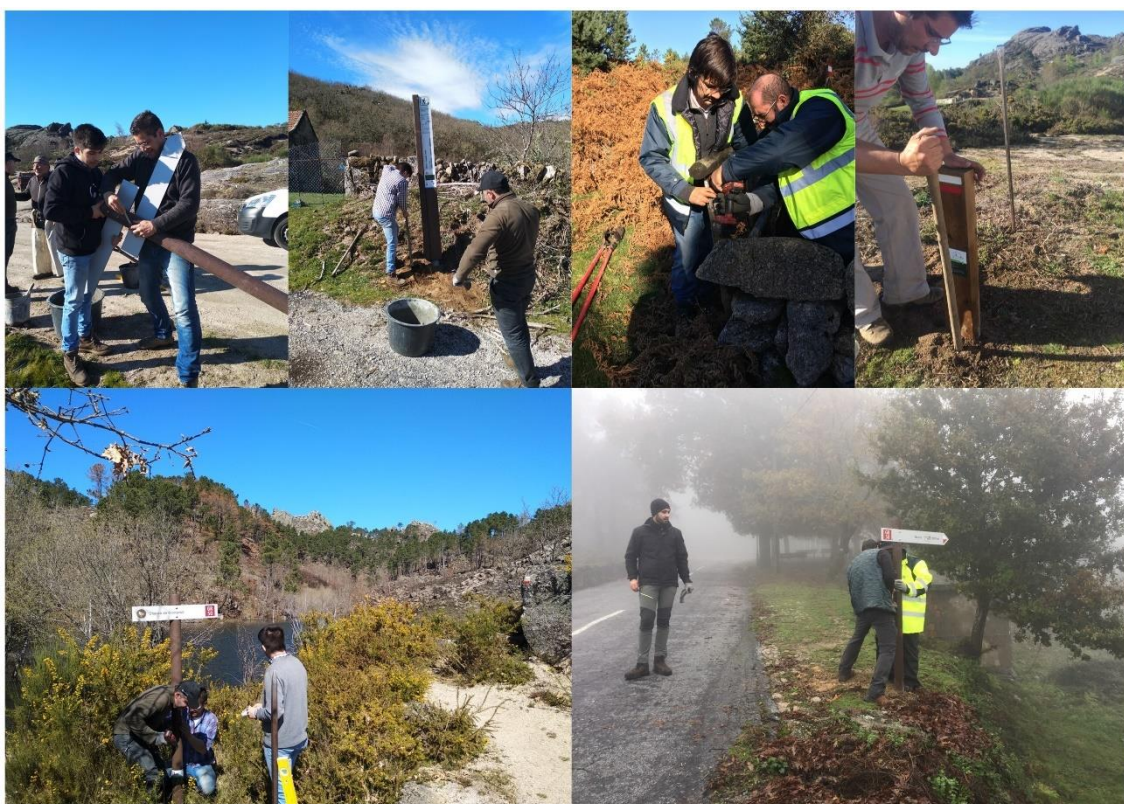
Figura 18 – Trabalho de colocação das estruturas de sinalização.
