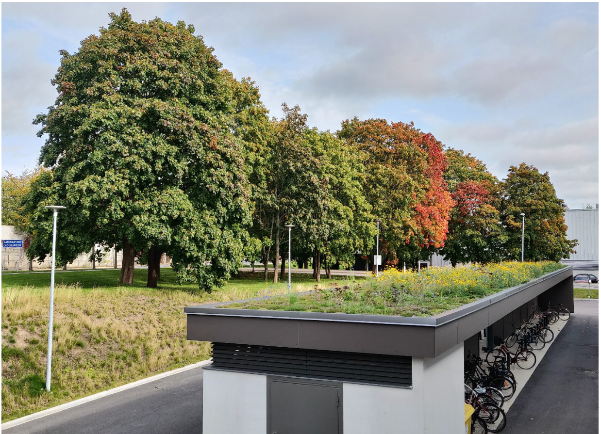
Kuva 4. Suomen ympäristökeskuksen Viikin toimipaikan pyöräkatokseen perustettiin keväällä 2020 kasvikatto, jonka pohjarakentamisessa on käytetty betonituotannon sivuvirroista saatua materiaalia ja järviruokoa turpeen sijasta. (Kuva: Hanna Nieminen).
