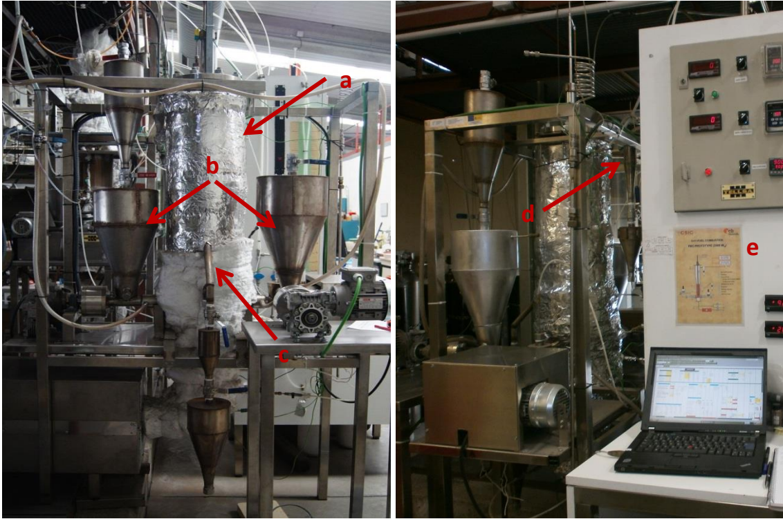
Figura 4.4. Vista general de la instalación. a) Combustor, b) tolvas de sólidos, c) drenaje de sólidos, d) ciclón y e) control y adquisición de datos.
