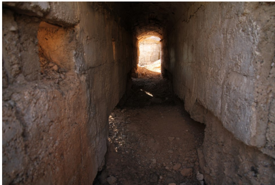
Nido de Ametralladora al finalizar los trabajos de limpieza y vista de las galerías de tiro de la zona norte
