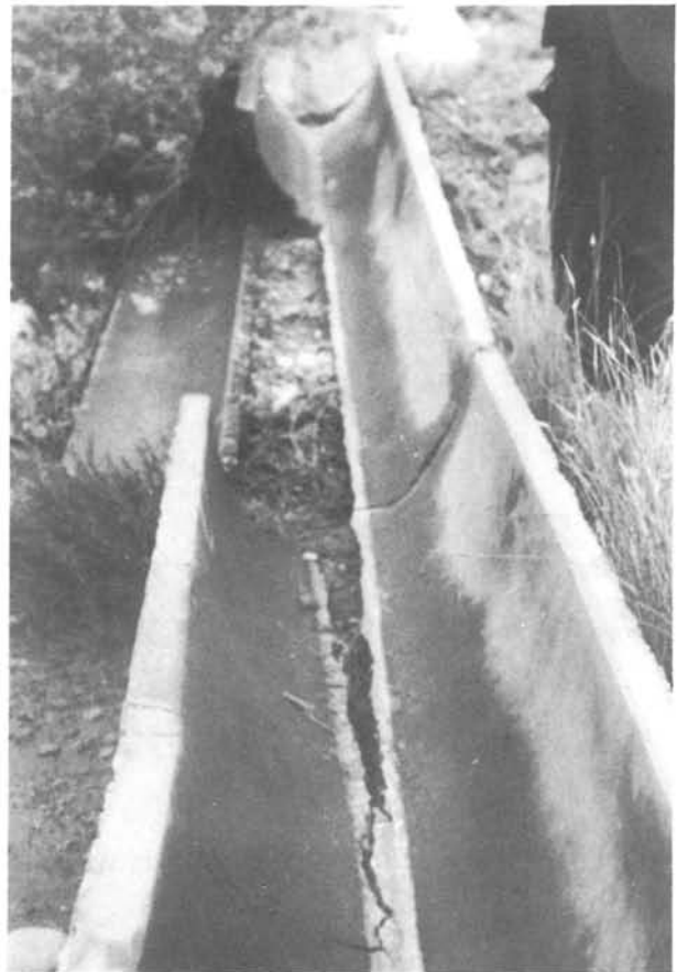
Fig. 1. —Canaleta para conducción de agua.
