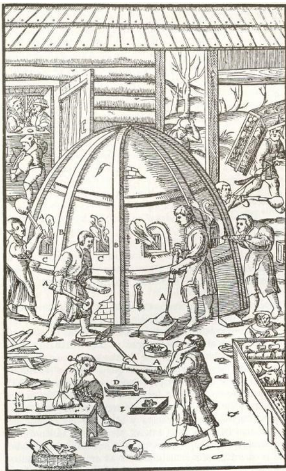
FIG. 5.8. Horno de fabricación de vidrio según Agricola (ca. 1550).
