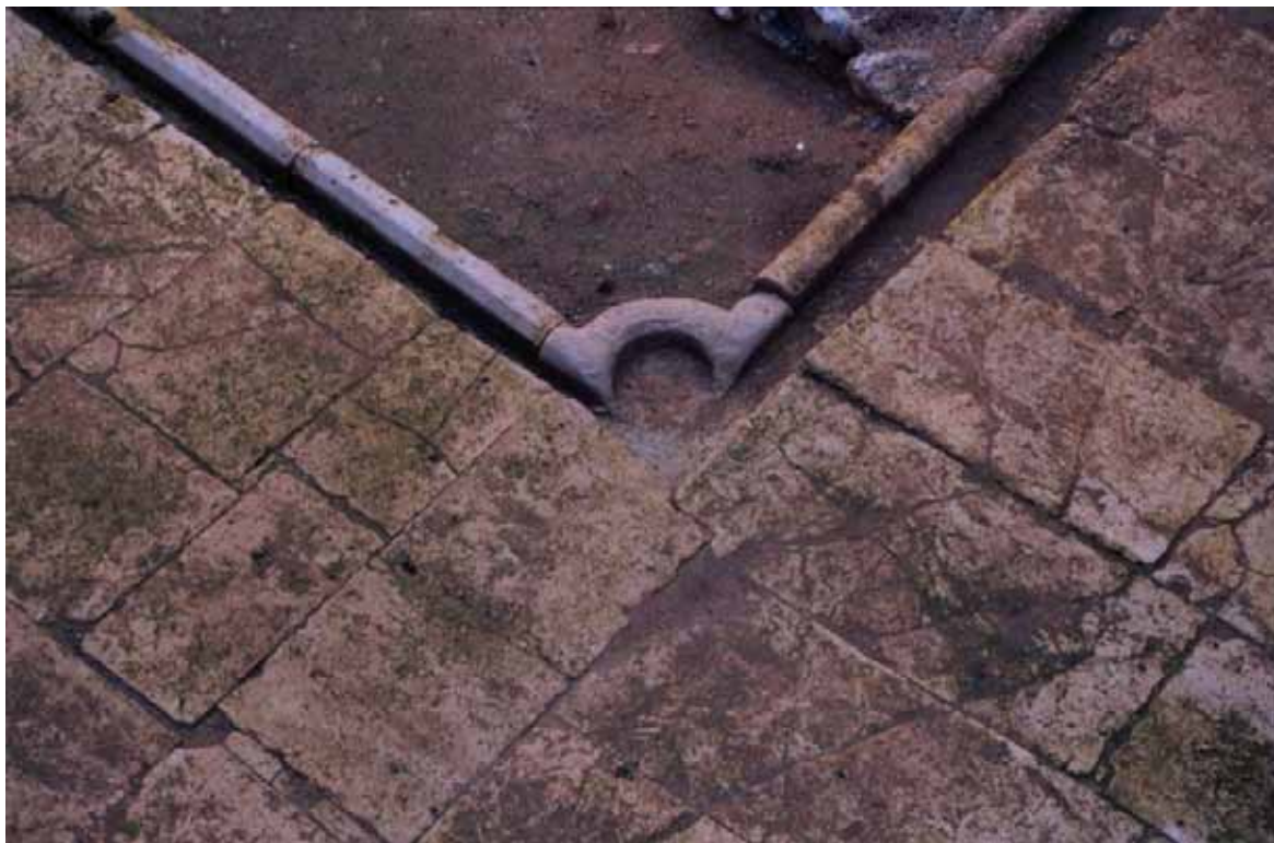
Fig. 161. Orihuela, calle Hospital. Visión parcial del patio de una casa andalusí. Obsérvese el canalillo perimetral conformado por piezas de piedra labrada; las de los ángulos eran de forma ultrasemicircular para reforzar los puntos en donde caían las aguas de lluvia recogidas en los tejados
