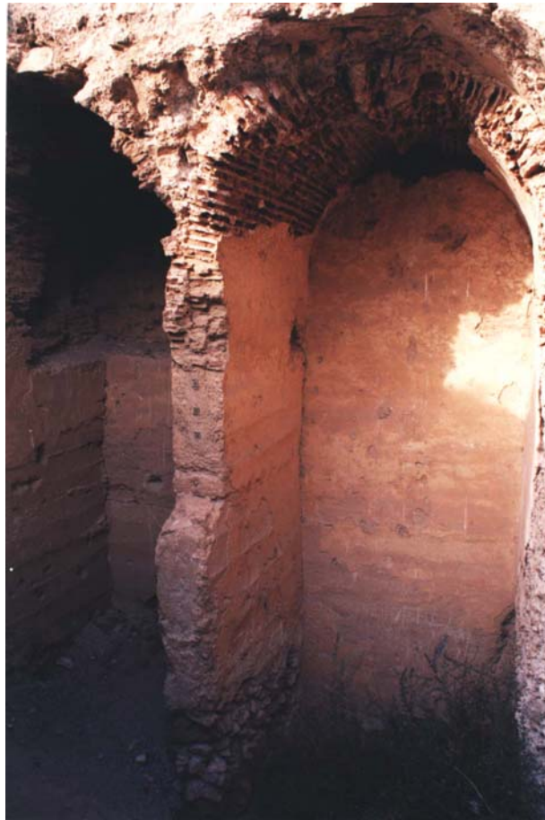
Fig. 97. Monteagudo (Murcia). Castillo. Tercer cuarto del s. XII. Obsérvense los alzados de tapial de hormigón y las bóvedas de ladrillo sobre las que se extiende un relleno de argamasa que permitió crear una superficie aterrazada
