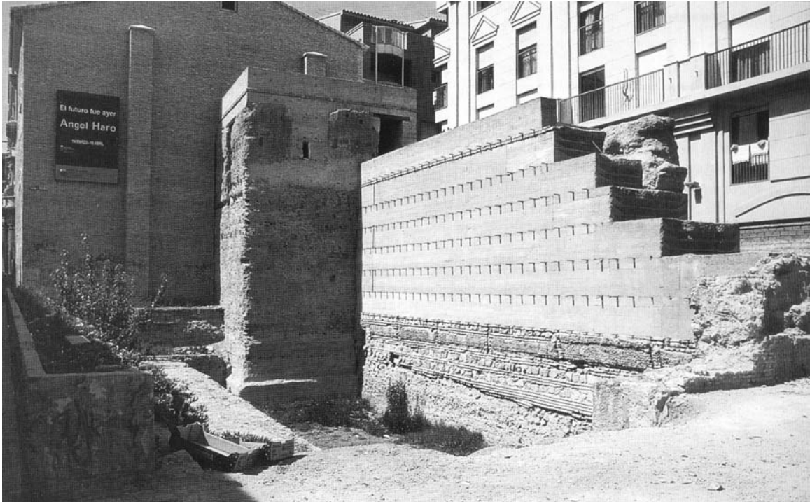
Fig. 122. Murcia. Tramo de muralla del antiguo convento de Verónicas (Martínez López, 1999b)
