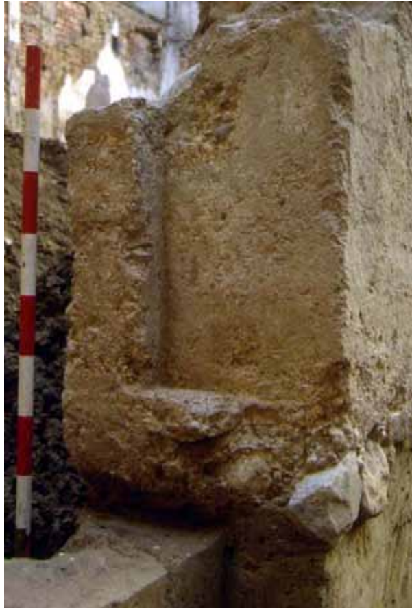
Fig. 87. Murcia. Casa A de calle Platería, nº 14 (s. XII). Detalle de la jamba con la mocheta encofrada en la obra de hormigón (Jiménez Castillo y Navarro Palazón, 1997)
