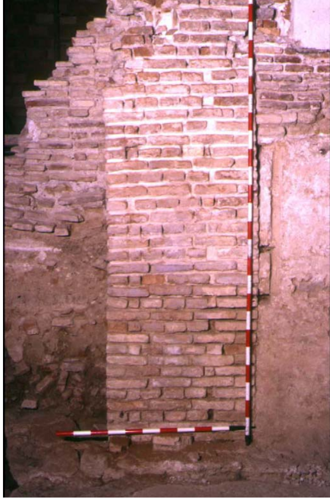
Fig. 99. Murcia. Qasr al-Sagîr . Segundo cuarto del siglo XIII. Cimentación de ladrillo de la jamba occidental del vano de acceso al salón norte
