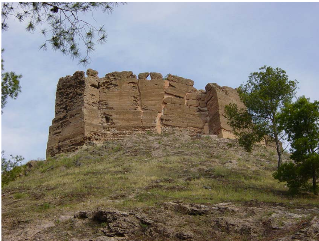
Fig. 44. Castillo del Verdolay. Recinto superior visto desde el exterior
