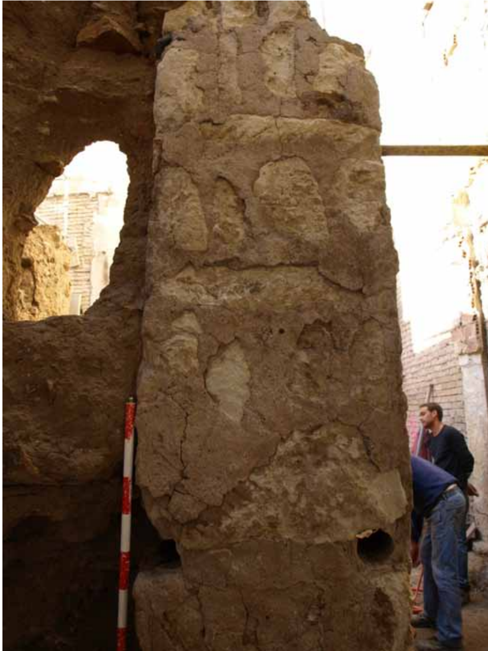
Fig. 150. Murcia. Machón de sillarejos de calcarenita tomados con argamasa que reforzaba la parte central del frente de un torreón en calle Nicolás Ortega (García Ruiz, 2012, p. 49)
