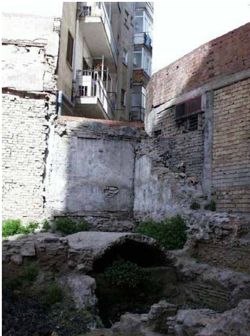
Fig. 167. Solar de Calle San Francisco. Detalle de la bóveda de ladrillos que cubría el foso o Val de San Antolín. El recorrido de esta infraestructura generó en este tramo una servidumbre entre fincas
