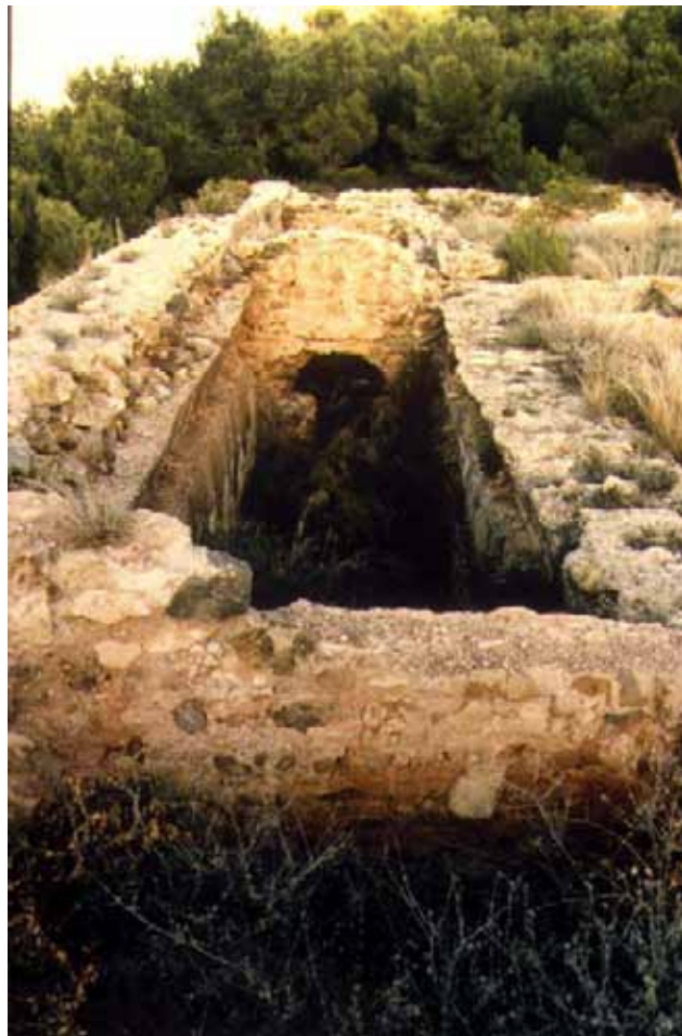
Fig. 98. Murcia. Recinto superior del Portazgo. Tercer cuarto del siglo XII. Obsérvese en la parte superior de la obra de hormigón el retalle para apoyar la bóveda de ladrillo que debía cubrir la cruzja
