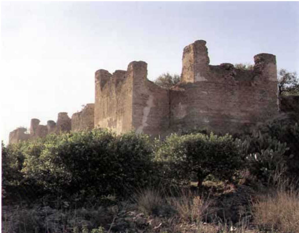
Fig. 95. Monteagudo (Murcia) Castillejo. Vista de la esquina (entrante) noreste del palacio. Tercer cuarto del s. XII
