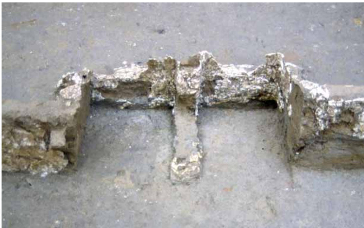
Fig. 305. Solar de calle Cortés. Casa 6. Doble cámara de aireación fabricada con adobes (Muñoz López, 1999a)
