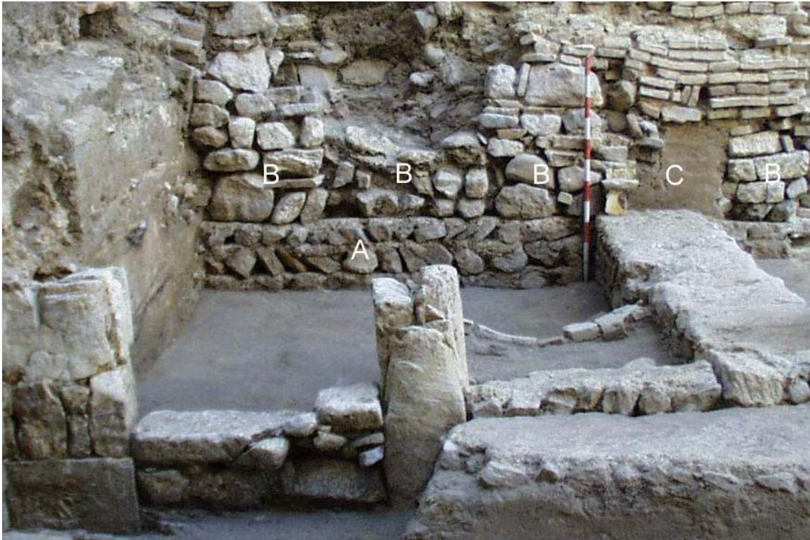
Fig. 76. Murcia. Casa nº 1 de calle San Pedro (ss. X-XI). Apréciase al fondo el muro medianero compuesto por un zócalo de mampostería (A) conservado íntegramente, mientras que su alzado original de adobes ha desaparecido, sustituido por reparaciones de mampostería en bataches (B). El único tramo que no ha sido reparado y en el que se conservan algunos adobes originales es aquél en el que entestaba el muro que subdividía la crujía (C).
