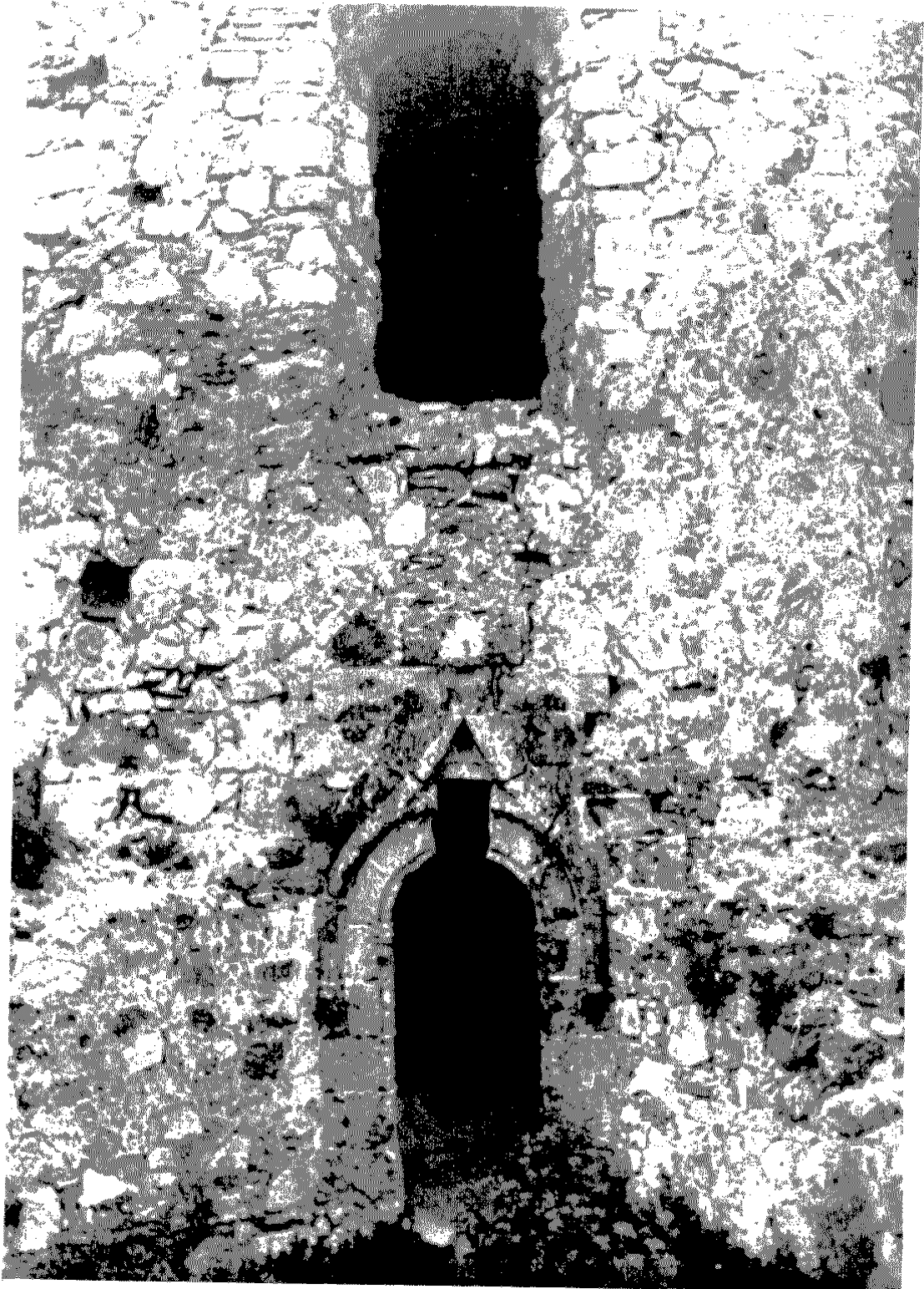
Figura 30.- Puerta de arco de medio punto peraltado con gablete del castillo de Santiago de Sanlúcar de Barrameda.
