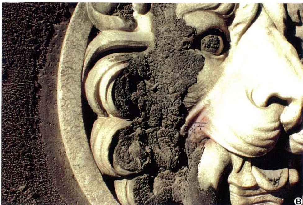
Figura 3.- a : Fachada del Palacio Barberini (Roma). b : Detalle de la costra negra formada en una de las figuras de los pilares de la verja.
