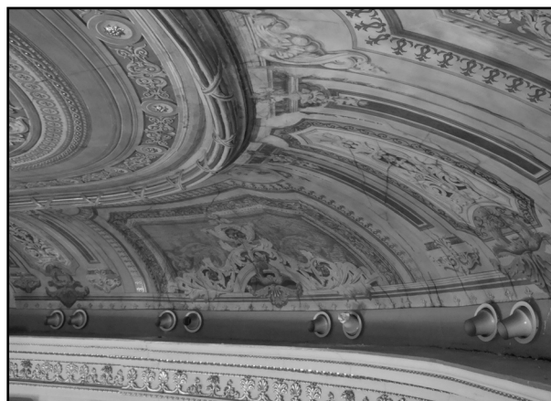
Figura 3. Plafón central con moldura perimetral de separación de la semibóveda y salidas de los conductos de climatización encima de la cornisa (intradós).
