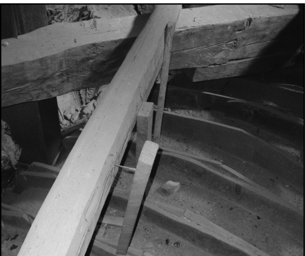
Figura 6. Uniones a viga puente mediante piezas clavadas.
