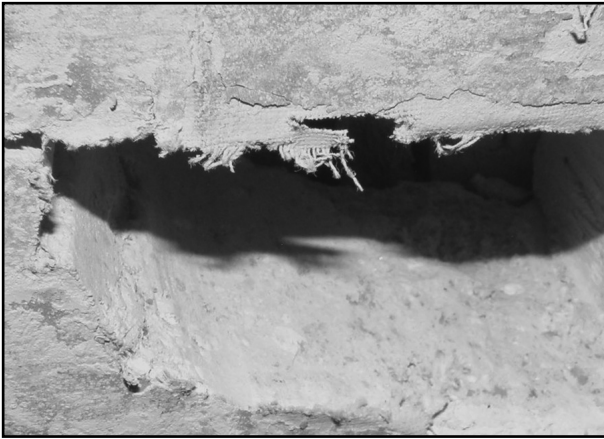
Figura 11. Sección del intradós del plafón de la bóveda cubierta por la tela pintada (fotografía tomada después de haber realizado la cata).
