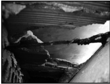
Figura 9. Interior de la cornisa: anclaje de sujeción.
