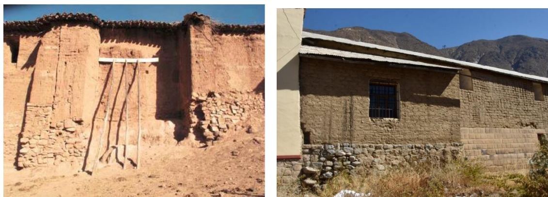
Fig. 109. Comparación de mampostería de piedra desordenada ente las iglesias de Kuñotambo y San Juan Bautista de Huaytará.
