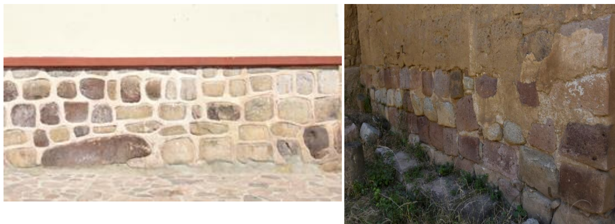
Fig. 61. Mampostería de roca en la parte frontal y posterior de las torres laterales
