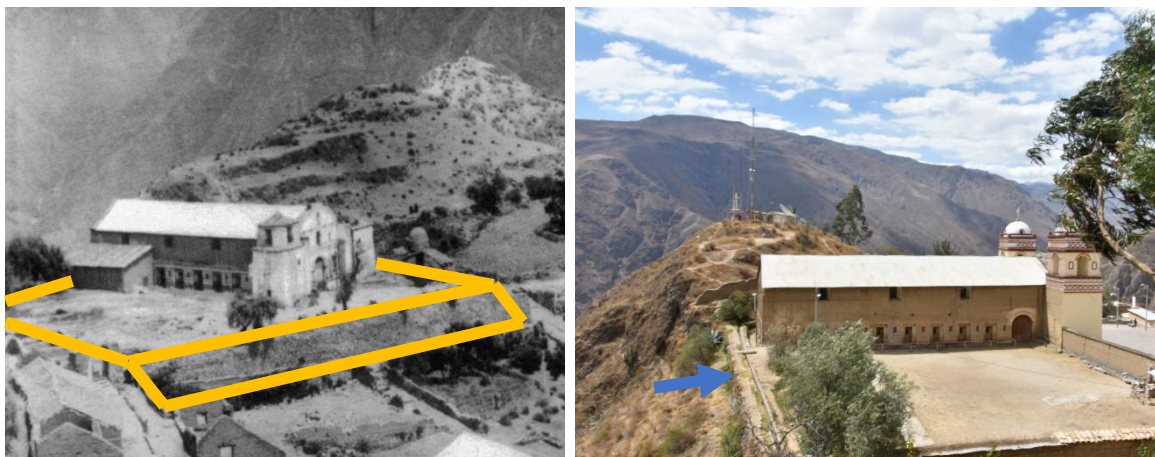
Fig. 75. Plataforma de relleno (izquierda) y canal de agua que pasa por la parte posterior de la iglesia San Juan Bautista.
