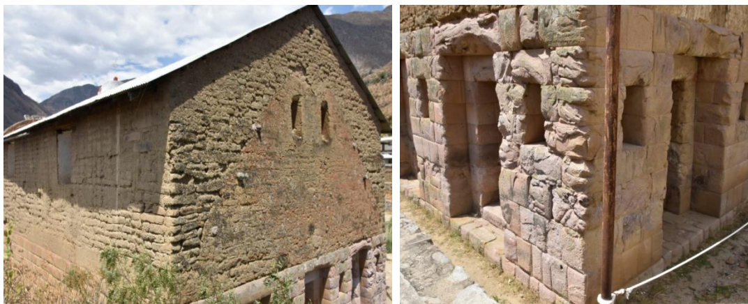
Fig. 77. Daños por erosión en las paredes de Adobe y Muro de Roca tipo Inca
