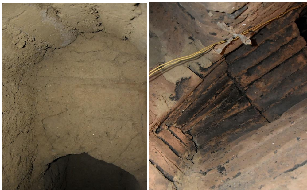
Fig. 71. Morfología de las entradas tipo arco construidas con unidades de adobe.
