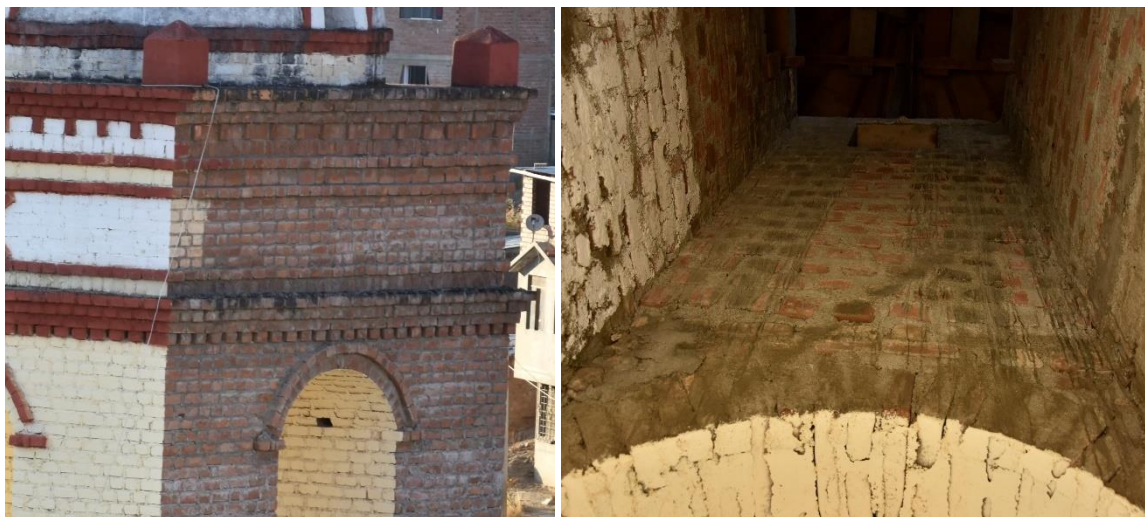
Fig. 57. Mampostería contemporánea de ladrillo artesanal y mortero de cemento - Arena.
