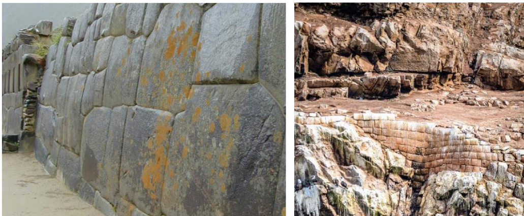
Fig. 22. Estructura tipo Inca con bloques de roca cubicas, Muro de contención para plataforma(izquierda); Para ampliar la calzada del camino imperial Pisco en la costa del Perú (derecha)
