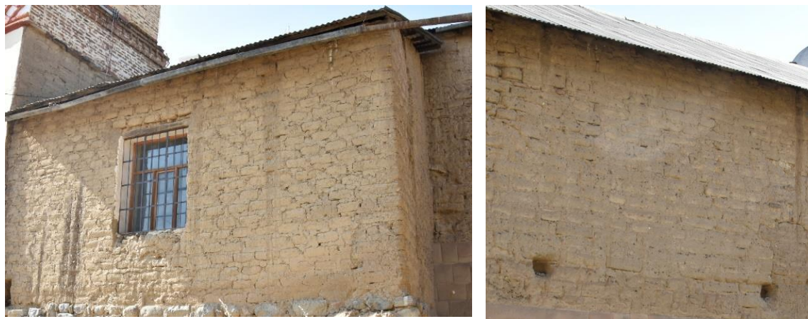
Fig. 60. Muros de adobe, sobre la sacristía Norte (derecha) y sobre el muro del lado Sur (izquierda)
