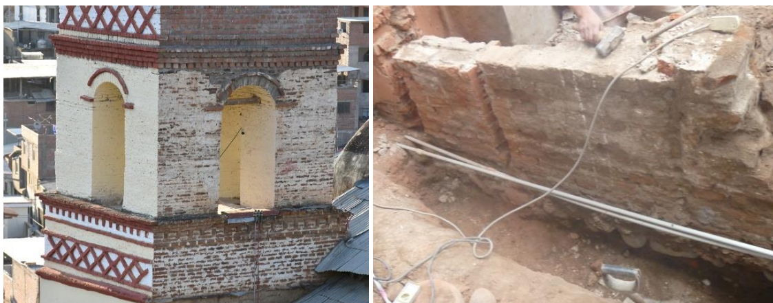
Fig. 106. Tipo de mampostería de ladrillo antiguo con mortero de cal en ambas imagines presente en la iglesia Huaytará (izquierda) y mampostería encontrada en el hotel "Comercio" (derecha)
