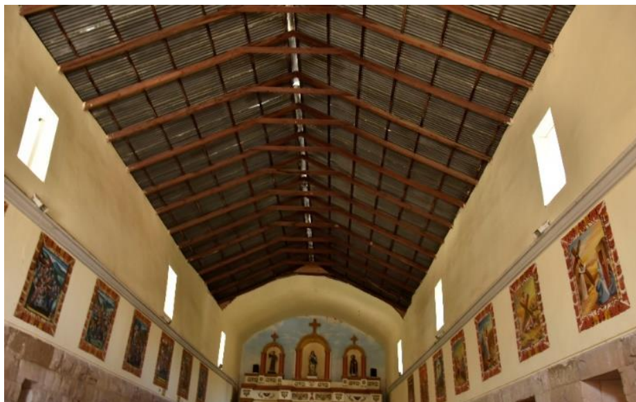
Fig. 64. vista interior de la cobertura de la Iglesia San Juan Bautista.
