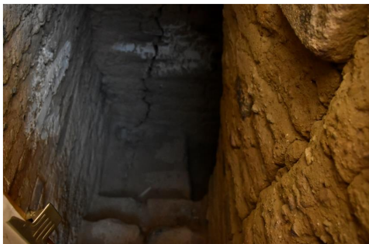
Fig. 153. Comparación de los daños obtenidos por el modelo numérico y en la fotografía del corredor interior de la torre Norte.
