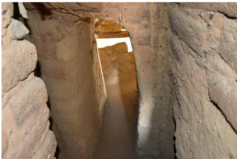
Fig. 79. Apertura realizada en la torre norte en forma de arco para la comunicar entre la sacristía a el corredor interno de la torre.
