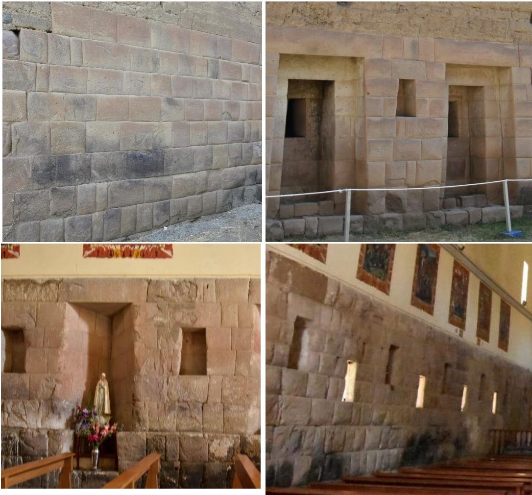
Fig. 59. Forma de acomodo de las mamposterías exteriores (arriba) e interiores (abajo)
