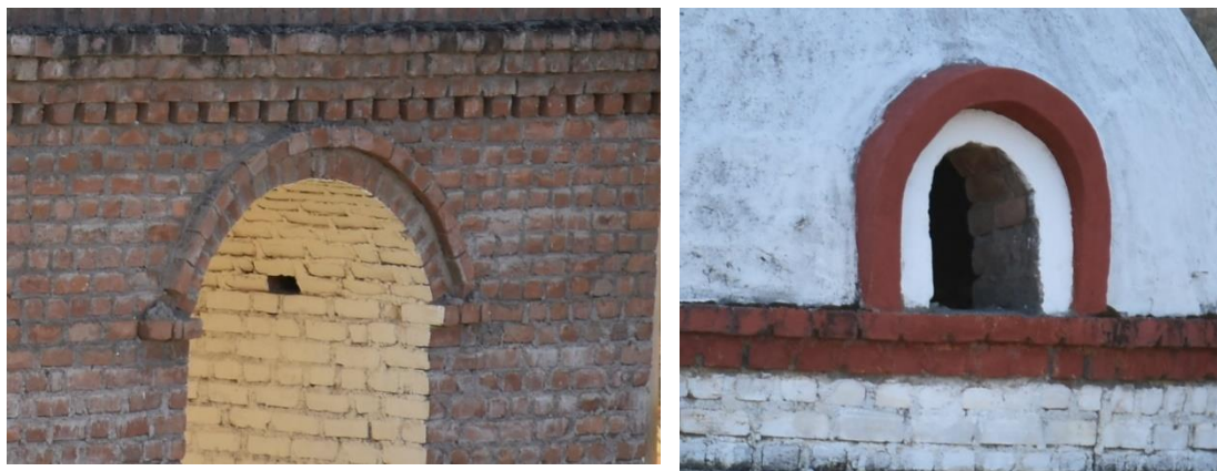
Fig. 68. Morfología del arco de ladrillo contemporáneo, en la columna y parte superior de la torre Sur (izquierda), en la cúpula de las torres Norte y Sur (derecha).
