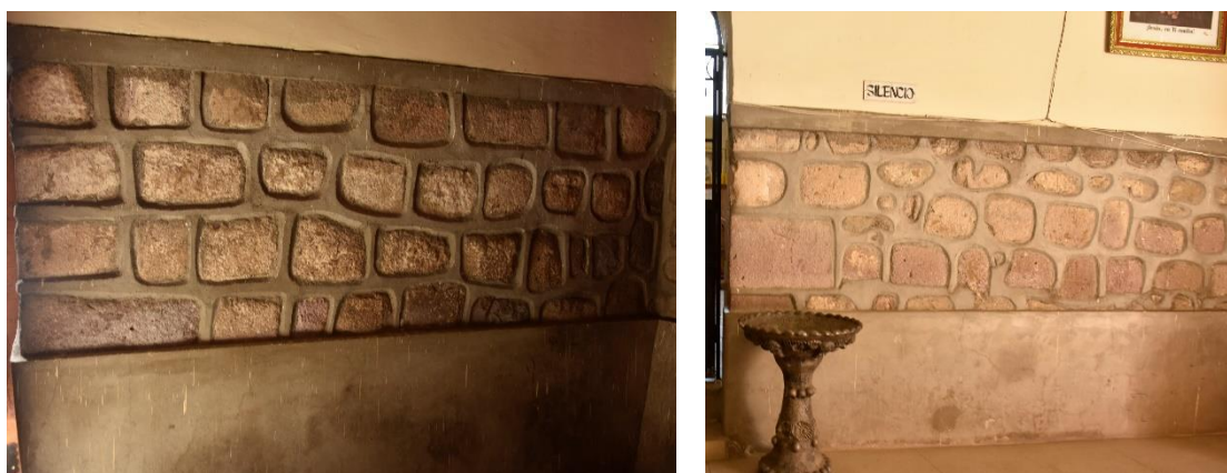
Fig. 72. Morfología de a mampostería de Roca y barro, en la fachada de la nave(izquierda) y el muro norte de la nave (derecha).
