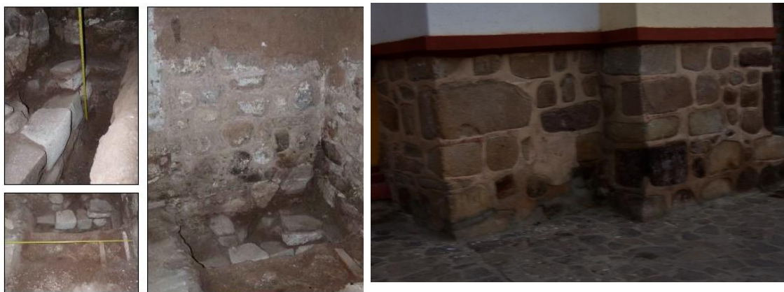
Fig. 108. comparación de mamposterías de piedra, Casa Arones Cusco (izquierda) y Iglesia san Juan Bautista (derecha)
