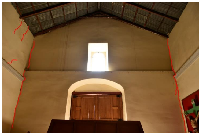
Fig. 152. Fotografia donde muestran las grietas encontradas en la inspección ínsito en la fachada principal exterior e interior
