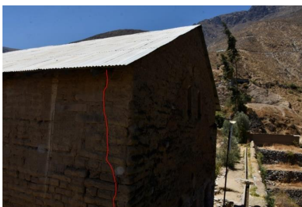
Fig. 150. Fotografías de la correlación de patrón de grieta en las fachadas de los muros norte y sur.
