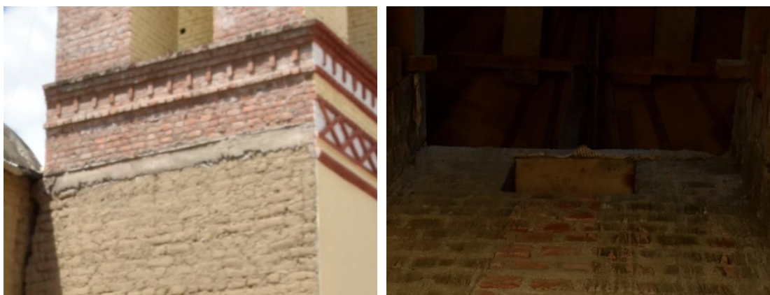
Fig. 63. Losa de Hormigón en la torre lateral Sur(izquierda) y en la base de la cúpula (derecha)
