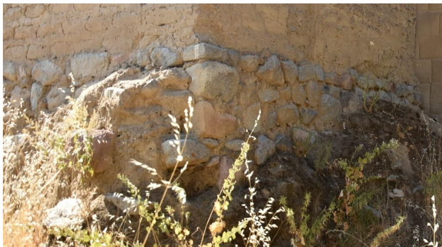
Fig. 73. Morfología de la piedra desordenada, cimentación de la sacristía.
