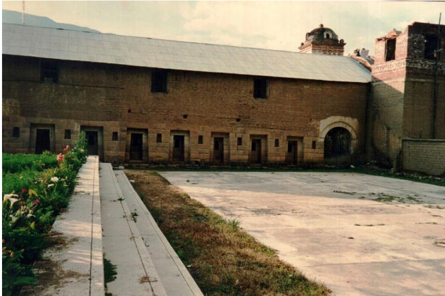
Fig. 41. Construcción de la Torre Sur con mampostería de ladrillo y mortero de cemento arena.
