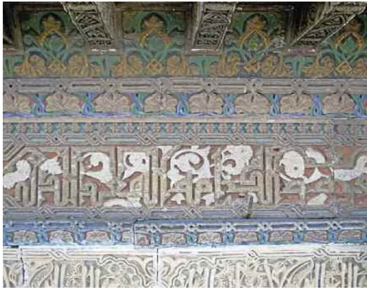
Fig. 27. Alicer del alero antes de su restauración
