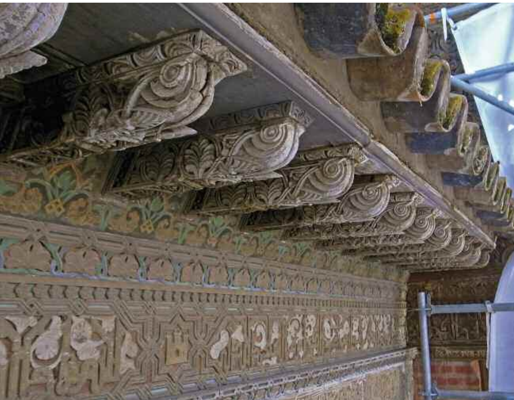
Fig. 33. Detalle de las vigas que soportan el techo de la galería, sin los casetones. Las vigas superiores son las mismas que forman los canecillos del alero
