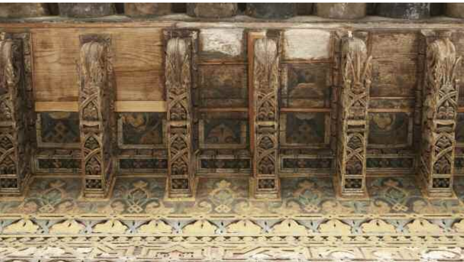
Fig. 30. Detalle del sofito del alero después de la limpieza y reintegración de la madera
