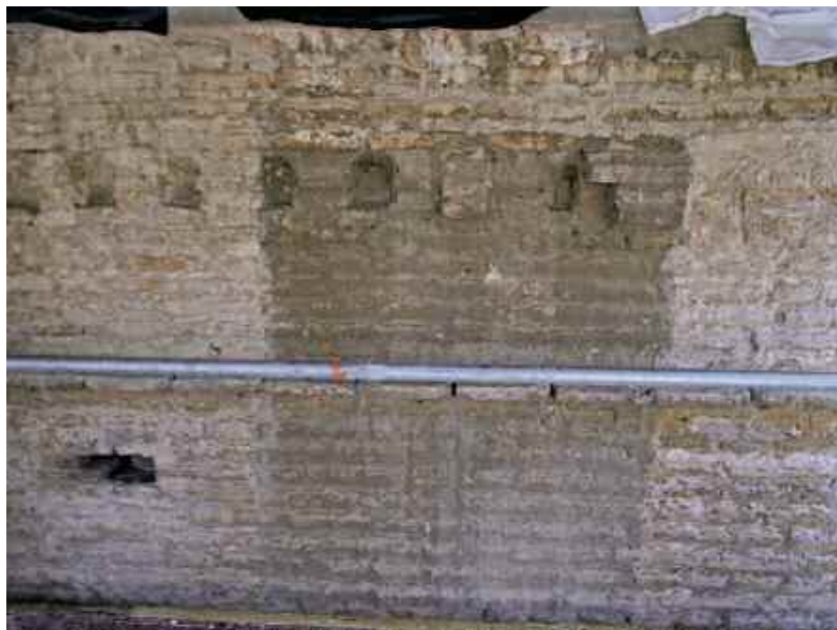
Fig. 21. Testigo temporal mostrando la suciedad que presentaba la fábrica de ladrillo antes de su limpieza
