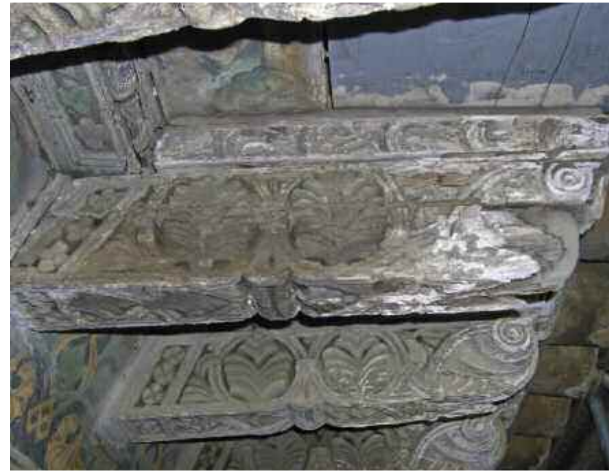
De arriba a abajo. Fig. 28. Detalle de los canecillos del alero antes de su restauración
