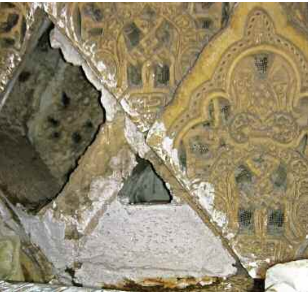
Fig. 24. Vista de la estructura interna de la trama de sebka al desmontarse varias placas desprendidas
