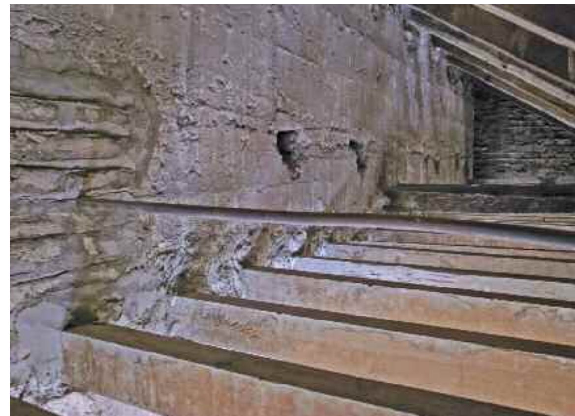
Fig. 9. Estructura de la cubierta de la galería. Las vigas inferiores son las que forman los canecillos
