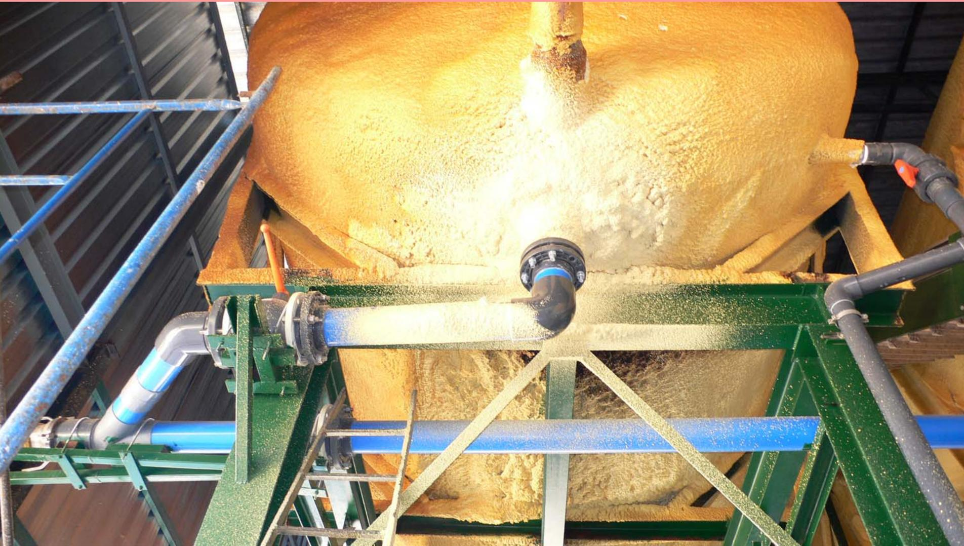
*Detalle de la salida del tanque. Cada uno hace unos 15000 kilos
