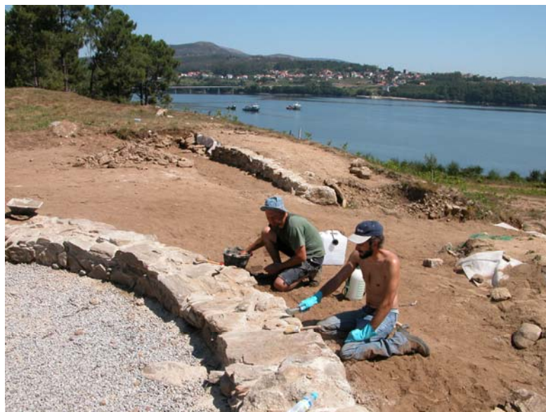
Figura 21. Consolidación do muro orixinal da construción UENEI01017.
