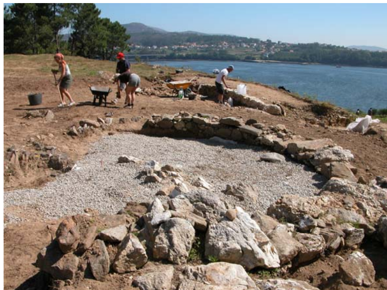
Figura 19. Recheo de grava do interior da construción para nivelar a superficie e crear unha capa de drenaxe.
