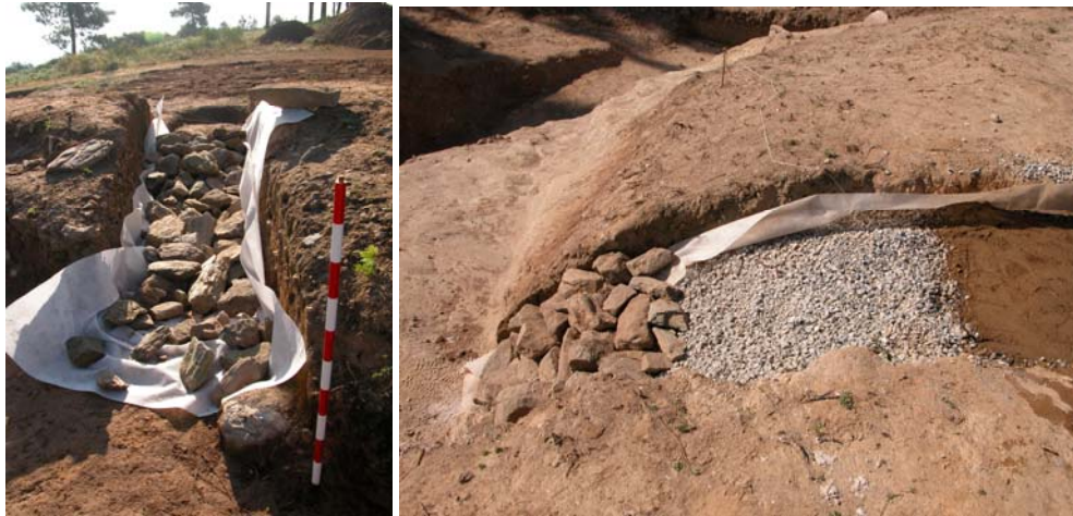
Figura 28. Capas de recheo da gabia de escavación do parapeto no lado S.
