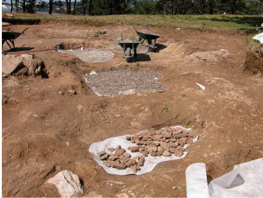
Figura 7. Nesta imaxe vemos as distintas capas de recheo nas fosas do sector 02, xeotéxtil+cachote+xeotéxtil+grava+xeotéxtil+terra vexetal.
