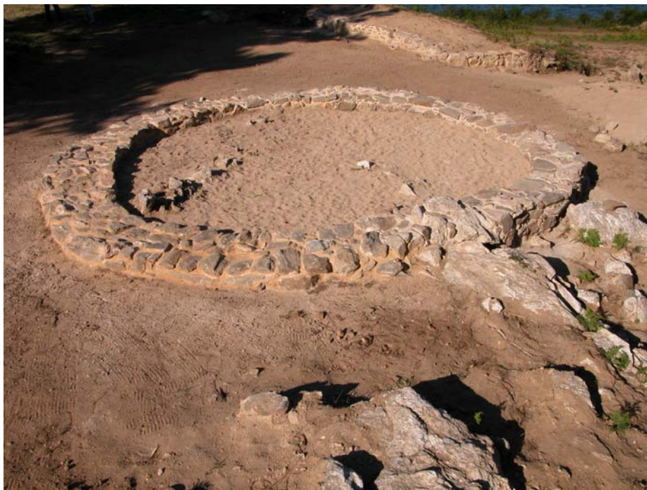
Figura 23. Vista dende o S do muro unha vez finalizada a restauración.
