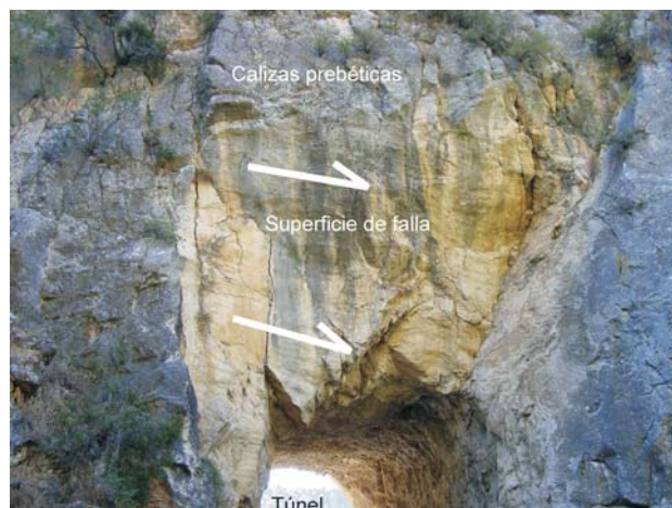
Figura 11.- Detalle de uno de las abundantes fallas menores visibles en el sector del túnel, cerca de Tíscar, en la línea principal de la falla de Tíscar. Se observa una estriación casi horizontal.
