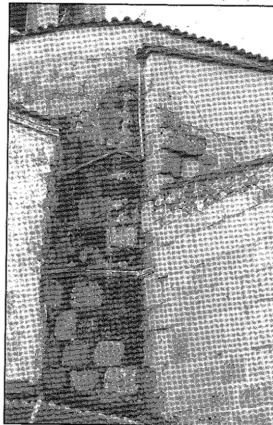
Fig. 38.- Basílica de Sta. Eulalia de Mérida. Muro de sillería del ábside y la sacristía norte.
