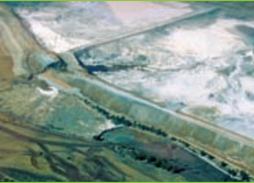
Zona de la rotura de la balsa minera de Aznalcóllar en los días posteriores al accidente.
