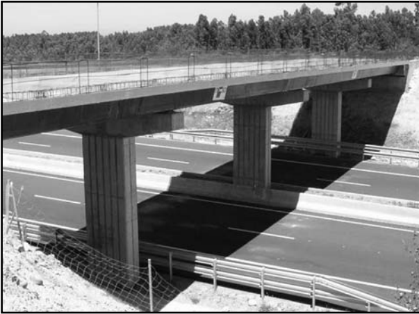
Figura 2. Vista general del paso superior de la Autovía del Cantábrico.
