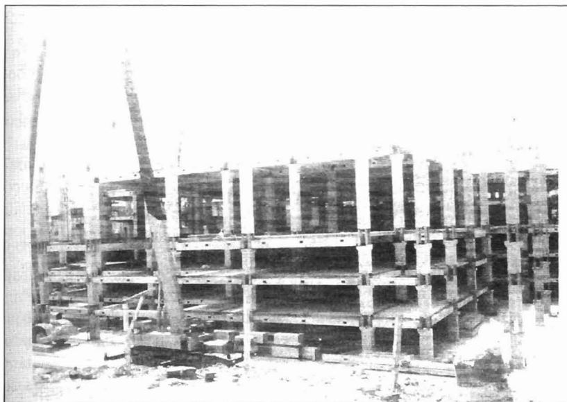
Figura 3.- Estructura prefabricada con pórticos de nudos rígidos (solución nudo hueco). Apropiaada para zonas sísmicas.
