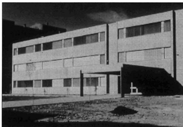
Figura 5.- Estructura prefabricada con núcleos rígidos (pantallas). Apropia para zonas sísmicas.
