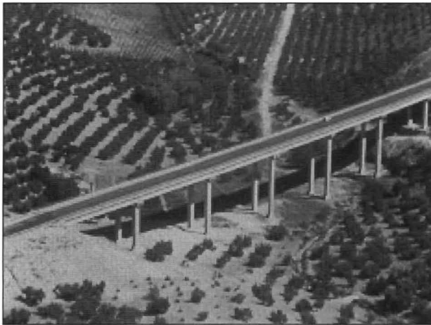
Figura 1.- Puento prefabricado en zona sísmica.
