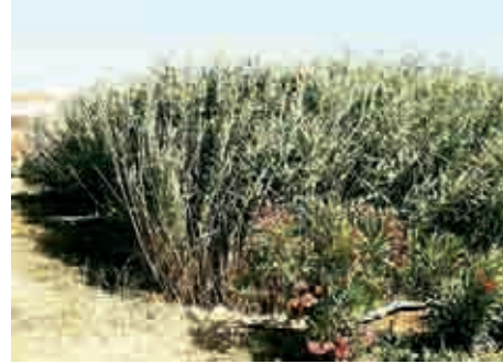
Humedal artificial de flujo subsuperficial horizontal para tratar aguas residuales de un agroturismo (Algarve, Portugal). Fotografía: Antonina Torrens.
