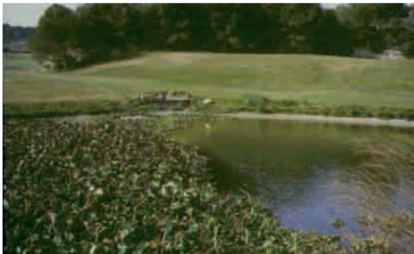
Laguna con macrófitos flotantes para la reutilización de aguas residuales en un campo de golf (Mallorca). Fotografía: Miquel Salgot.
