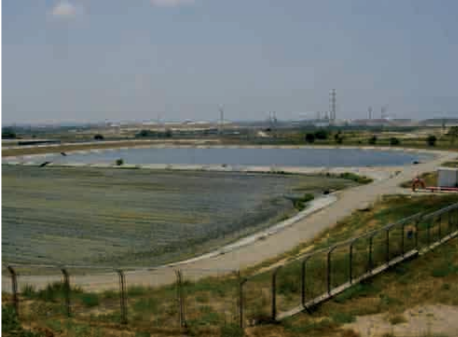
Balsas de recarga artificial en la Dan Region (Israel). Al fondo se ve una balsa inundada. Al frente la balsa está vacía y se aprecia el efecto de arado del fondo para evitar la colmatación. A la derecha se observa uno de los pozos de control.
