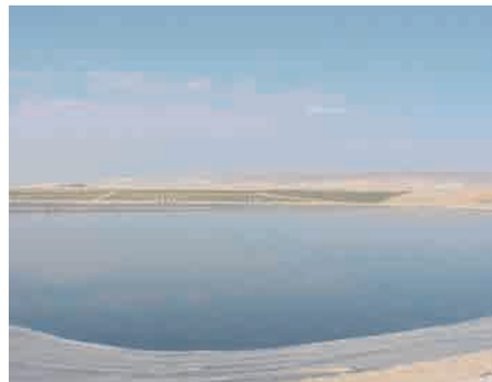
Lagunaje para la reutilización de aguas residuales para agricultura en el desierto del Negev (Israel). Fotografía: Laura Alcalde.
