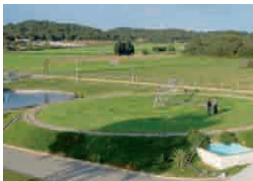
Sistema de infiltración-percolación con riego mediante un pivot con aspersores (Vall-llobrega, Girona). Fotografía: Miquel Salgot.
