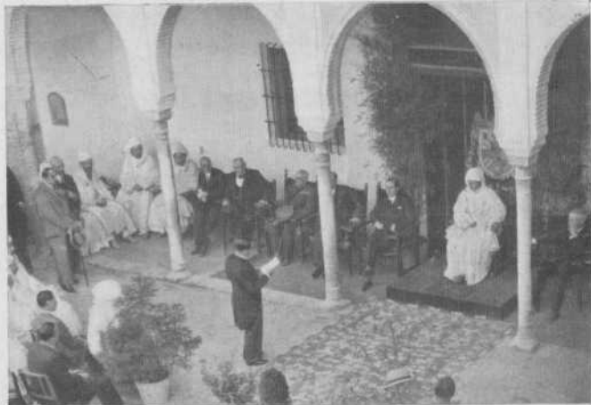
Visita del Jalifa de Marruecos a las obras de la Escuela.
