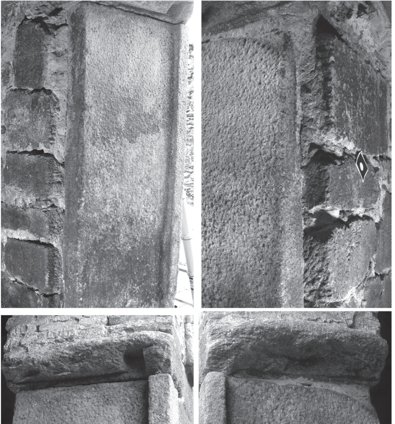
Fig. 21. Puerta E de acceso al aula. En las imágenes de la izquierda, jamba y mocheta N y en las de la derecha, jamba y mocheta S. Se aprecian los cortes practicados en ambas piezas
