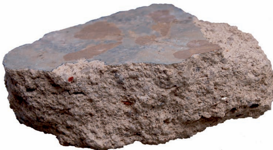
Fig. 37. Fragmento de pintura que debe corresponder a la parte central de la bóveda no conservada. Se aprecian perfectamente los pequeños fragmentos de arcilla en el mortero de preparación, así como algunos áridos más grandes en la última capa y el enlucido más fino sobre el que destaca la película pictórica azul del fondo y la decoración en ocre pintada encima. Una línea maestra marca el centro de la composición. (Depósito del Museo Provincial de Lugo)
