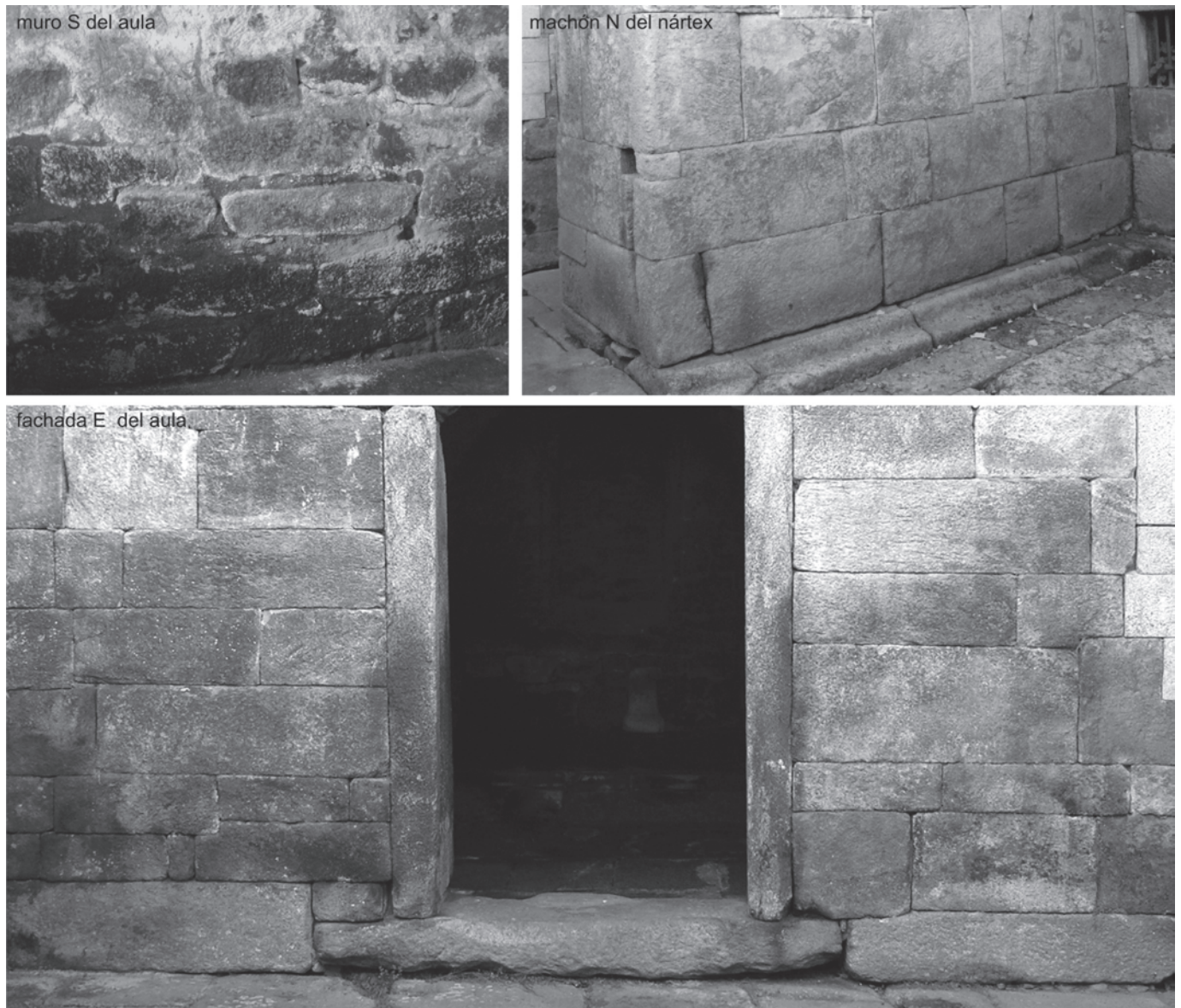
Fig. 6. Imágenes de los distintos aparejos de la fase I (muro interior y fachadas), en las que se aprecia también cómo los muros apoyan directamente sobre el enlosado
