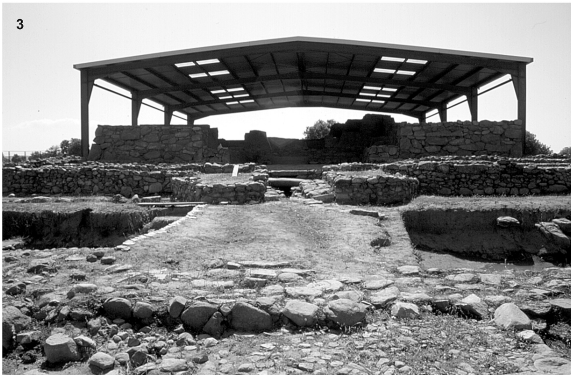
Figura 8. Aspectos de la estructura que antecede el foso de Cancho Roano interpretada como los cimientos de una puerta. 1. Planta general de Celestino 2001a. 2. Fotografía aérea retocada de 2000 (Helicópteros de Poniente); 3. Vista de la estructura, en primer plano (foto del autor 1997).
