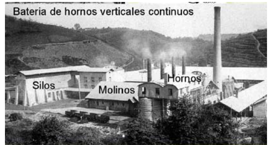
Figura 3: Las nuevas cementeras presentaban hornos, molinos y silos juntos (Ibáñez et al, 2001).
