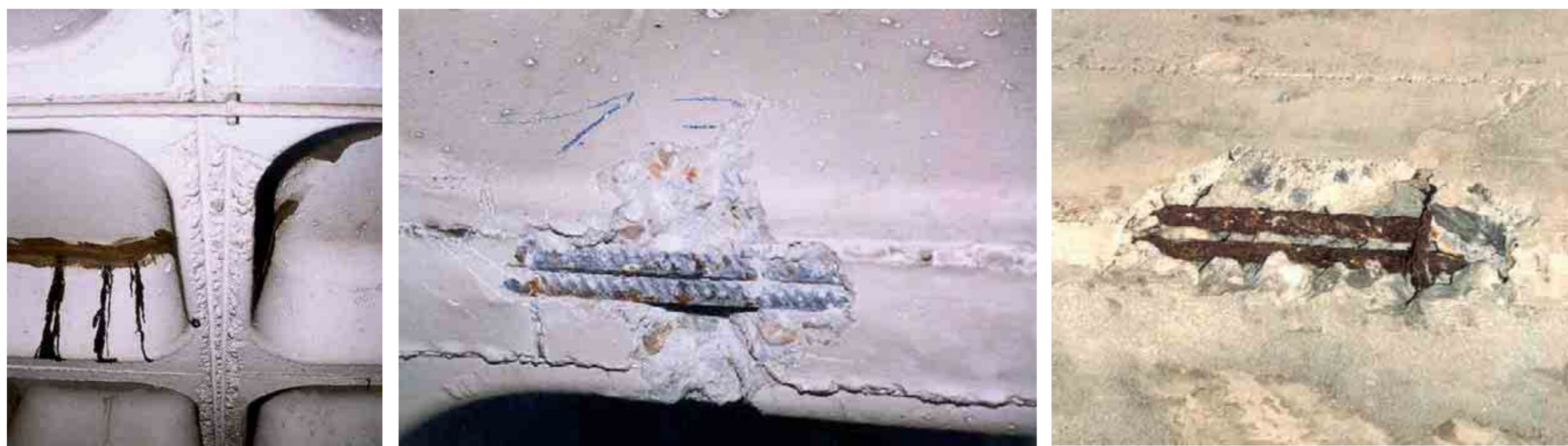
Izquierda: Figura 13. Estructuras afectadas por pérdida de adherencia.
