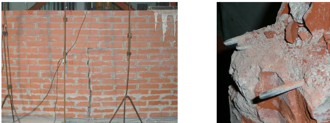
Fig.11. Detalles de la rotura del 3 er dintel; a) Imagen frontal de la rotura de las armaduras de tendel inferiores; b) Detalle de la deformación del armado en su rotura.
