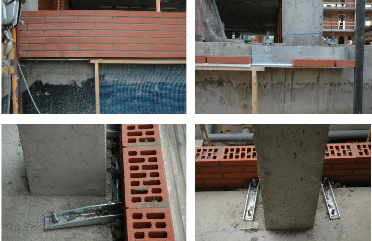
Fig. 13. Proceso constructivo del Apoyo Pi en la Fachada de un edificio residencial en Lleida.
