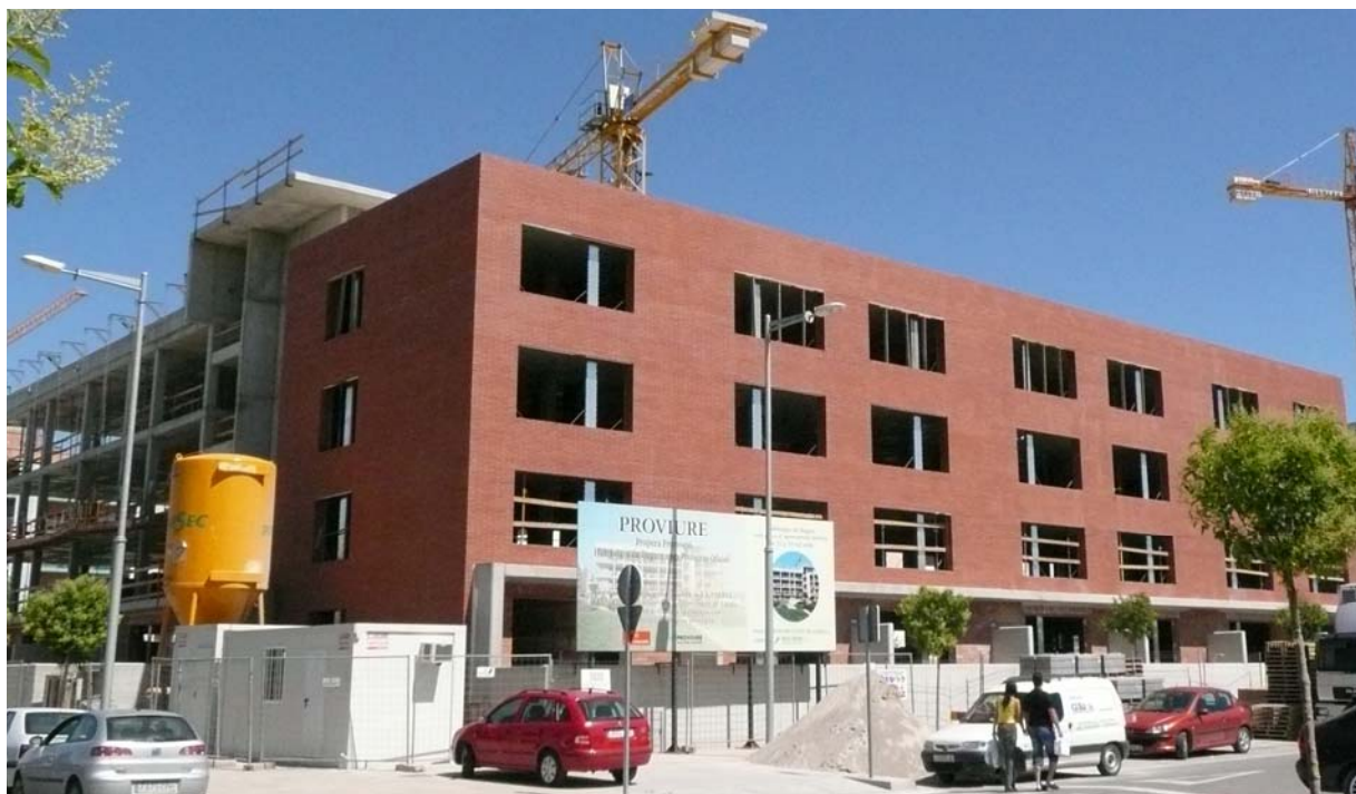
Fig.13.a) Edificio residencial en Lleida con fachada de ladrillo catalán (13,5cm) sobre Apoyos Pi.
