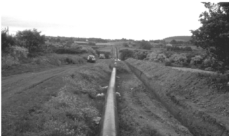
Figura 3. Pista y zanja del gasoducto, escenario dónde se han desarrollado parte de los trabajos arqueológicos.
