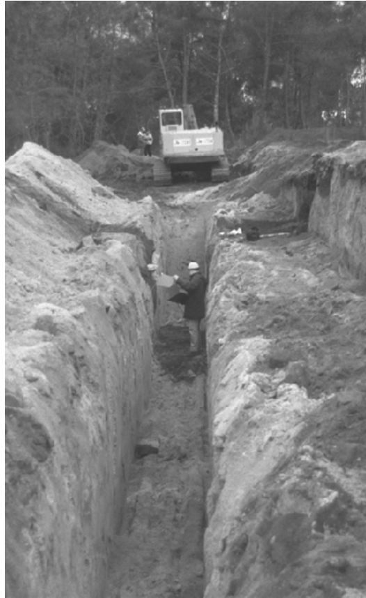
Figura 7. Registrando los restos arqueológicos en la zanja del gasoducto.
