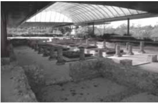
Figura 7. Cubierta de la casa de los repuxos, Conimbriga, Portugal.
