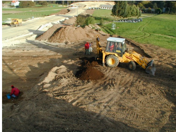
Figura 8. Limpieza por medios mecánicos del sector 01 de la excavación.
