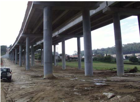
Figura 63. Vista actual de Agro de Ouzande tras las obras de construcción de la autopista.
