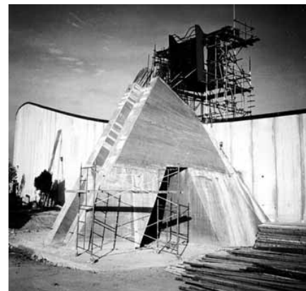
Fig. 10. Construcción de los soportes.
