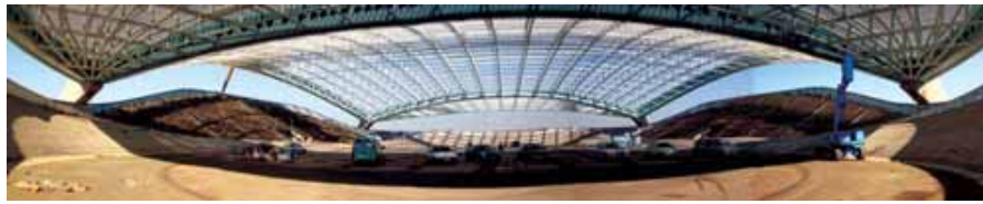
Fig. 53. Vista interior del recinto antes de la colocación de chapas.
