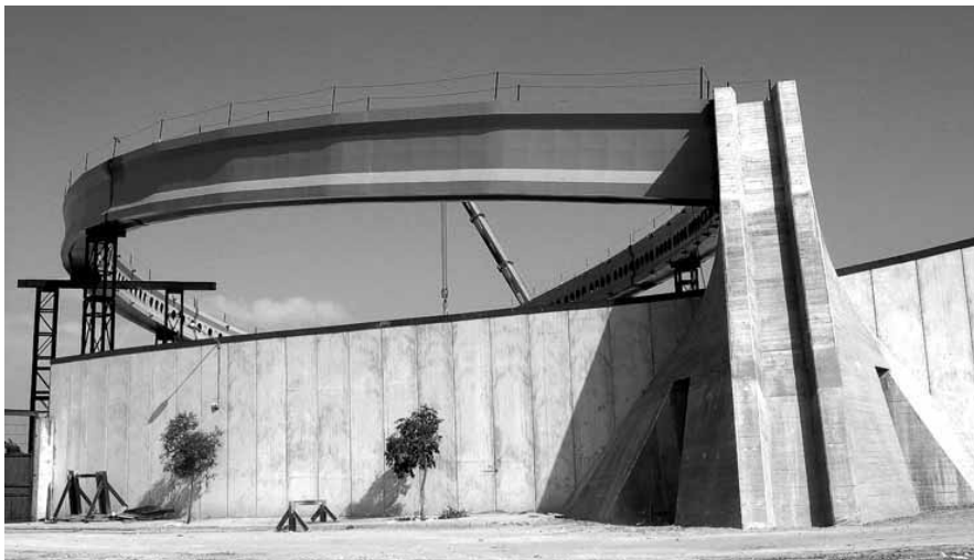
Fig. 11. Aspecto frontal y lateral del soporte con el canalón para el descenso del agua.
