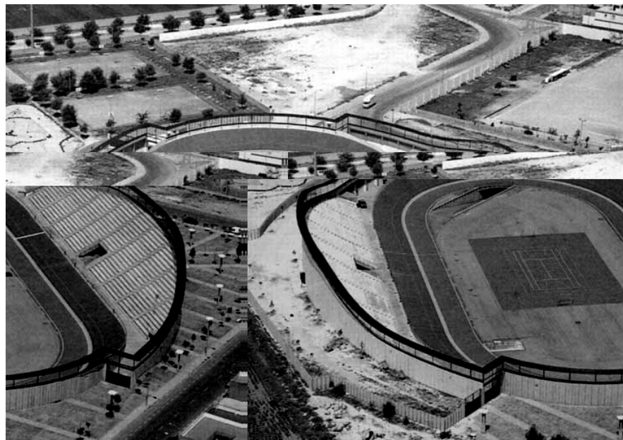
Fig. 1. Velódromo antes de ser cubierto.
