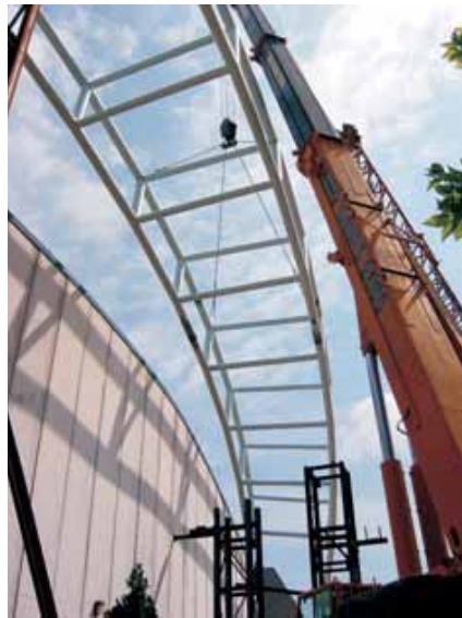
Fig. 42. Izado de la celosía principal.
