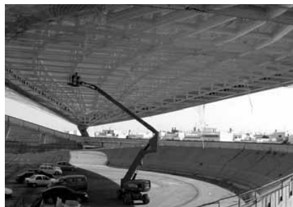
Fig. 50. Zona de voladizos con la primera chapa instalada.
