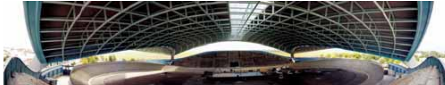
Fig. 54. Vista interior con la cubierta totalmente terminada.
