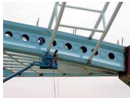
Fig. 45. Montaje de los cajones de borde.
