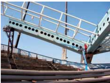
Fig. 44. Detalle de esta soldadura.
