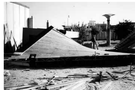
Fig. 9. Preparación del encofrado.
