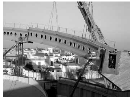
Fig. 15. Soldadura de las vigas a los soportes.
