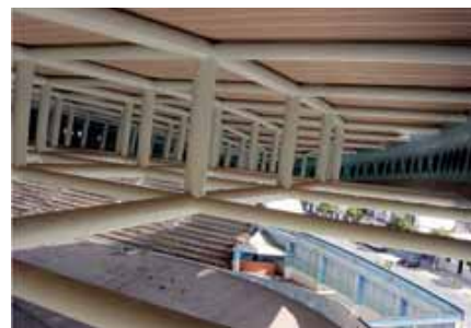
Fig. 56. Vista parcial con la cubierta terminada.
