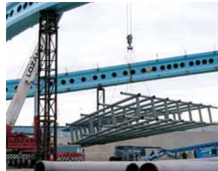
Fig. 39. Izado de los mismos.
