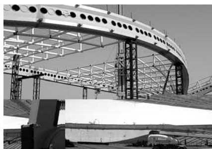
Fig. 47. Relleno de la celosía de los voladizos.
