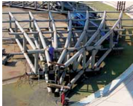
Fig. 38. Confección de los tramos de los puños en el terreno.
