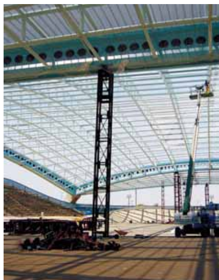
Fig. 58. Preparación del desapeo de un puntal.
