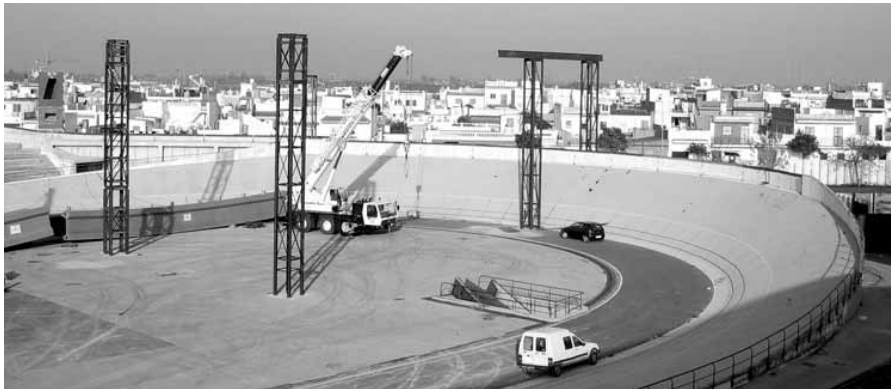
Fig. 28. Replanteo en obra con sólo seis puntales.
