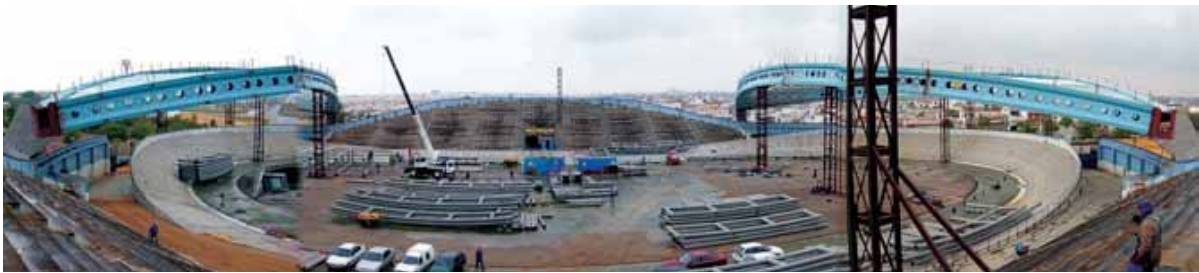
Fig. 37. Proceso completo de instalación de los arcos norte y sur.
