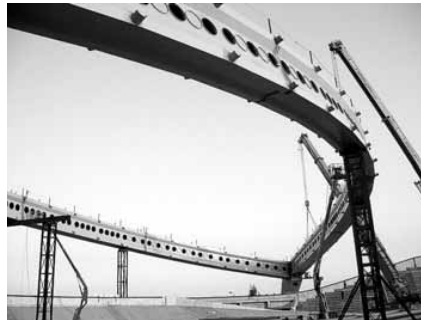
Fig. 33. Montaje de los arcos interiores.
