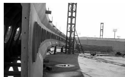
Fig. 30. Soldadura de dos tramos de cajón en el suelo.
