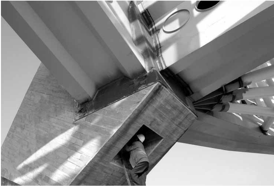
Fig. 17. Acceso al interior de los cajones.
