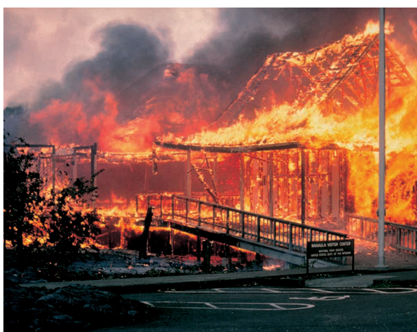
Figura 1.20a. Vista del Centro de Visitantes de Wahaula, en el Parque Nacional de Hawaii, incendiado en junio de 1989 por las lavas de la erupción del Pu'u 'O'o. (Fotografía de J.D. Griggs).
