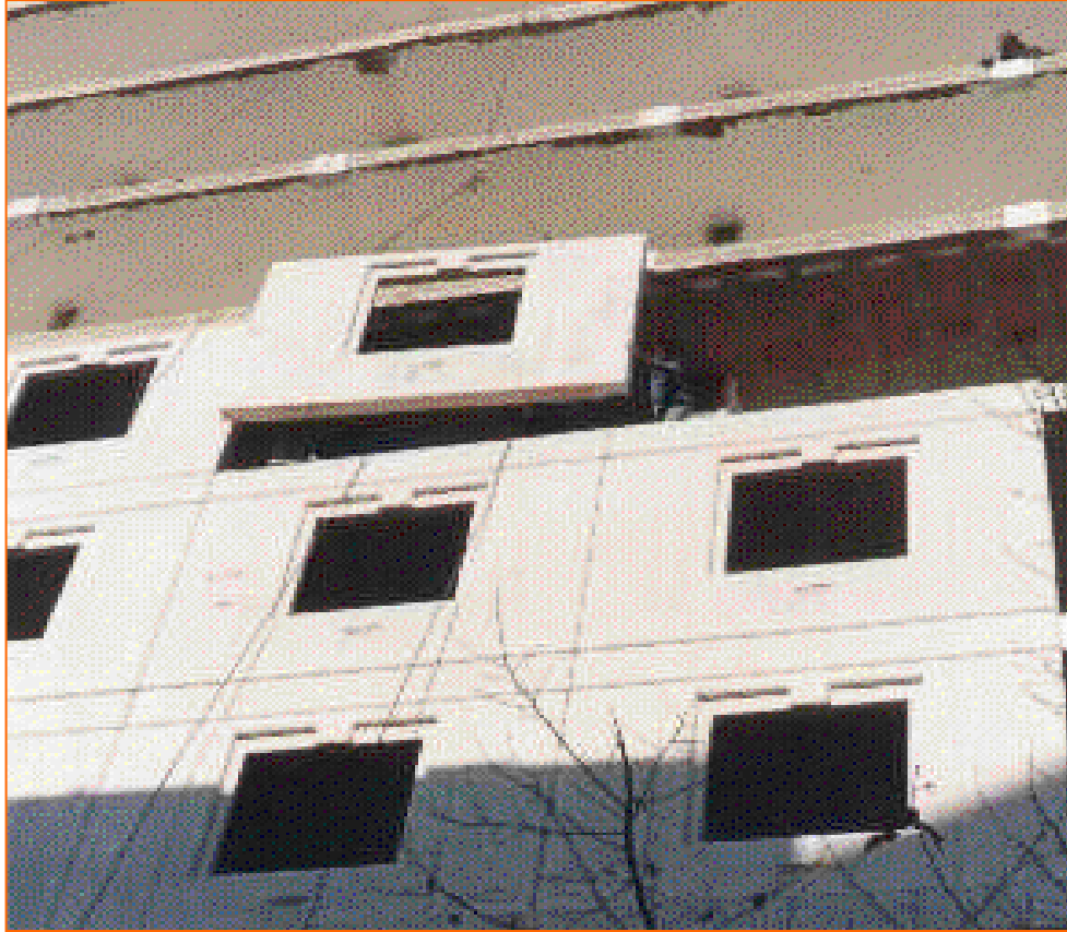
Figura 6: Colocación del panel en la fachada
