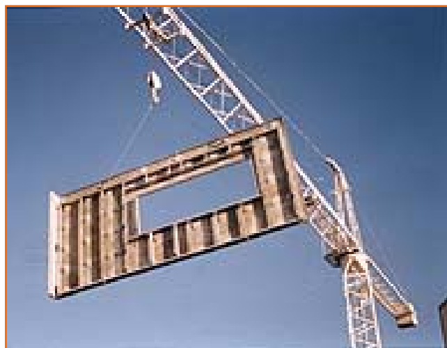
Figura 5: panel izado con grúa de obra
