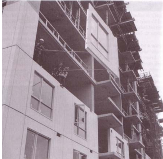
(Fig.5: Montaje de paneles prefabricados para edificio residencial de 26 plantas en San Diego, California (EEUU)) (Fuente: Lakeview/Centura Building System)
