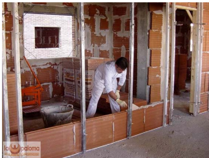
Sistema de partición con piezas de arcilla cocida de gran formato DIT 334-p Tabiceram. Cerámica La Paloma S.L.
