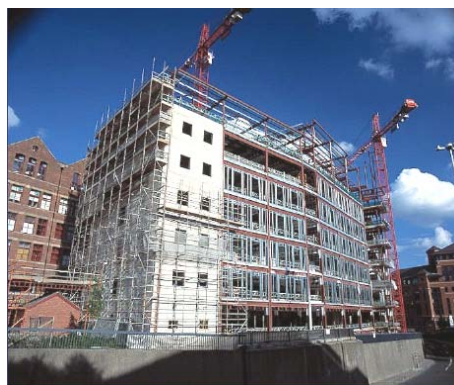
Fig.4.: ETICS sobre entramado ligero en edificio de varias plantas (Fuente: INCA)
