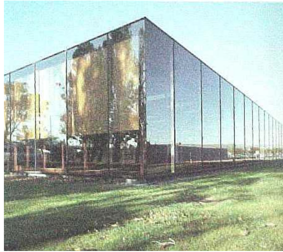
Fig.1-11. Edificio de oficinas de IBM en Cosham. En principio se realizó para ser desmontado, pero dado su buen resultado se ha conservado en pie.
