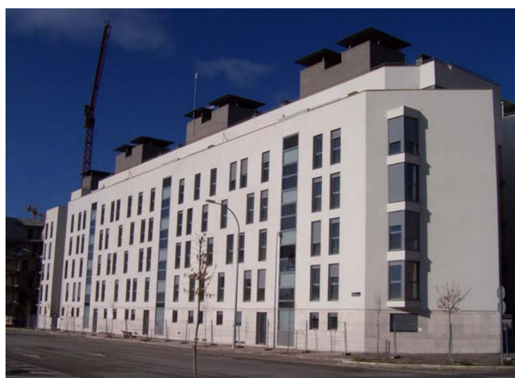
Fig. 8: Edificio "Proyecto Sunrise" para 139 viviendas sociales en el Ensanche de Vallecas (Madrid) (Fuente ELR)
