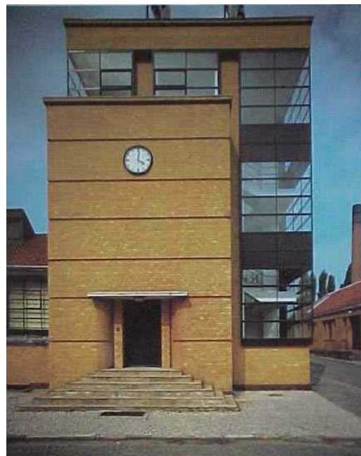
Fig.1-5. Factoría Fagus, con una envolvente de vidrio y acero de gran ligereza visual. Acero y vidrio han estado ligados desde un principio al lenguaje maquinista de la arquitectura del siglo XX.
