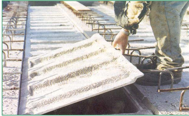
Figura 9: Encofrado perdido de GRC para forjado
