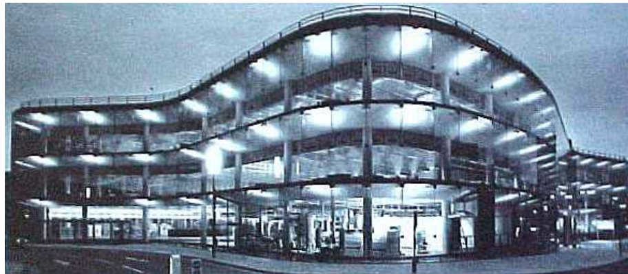
Fig.1-10. Visión nocturna del edificio Willis Faber & Dumas, en la que se aprecia la inexistencia de carpintería soporte del vidrio.
