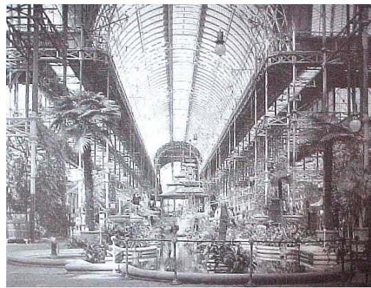
Fig.1-3. Interior del Crystal Palace, edificio completamente desmontable, en su segundo emplazamiento en Sydenham en 1854.
