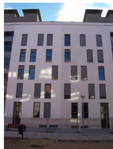
Fig. 11: Edificio "Proyecto Sunrise" para 139 viviendas sociales en E. Vallecas (Madrid)
