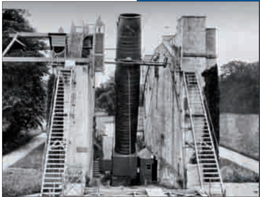
Figura 49.4. Leviatán. El telescopio reflector de 183 centímetros construido por Lord Rosse en 1845. Fuente: King H.C (1995).
