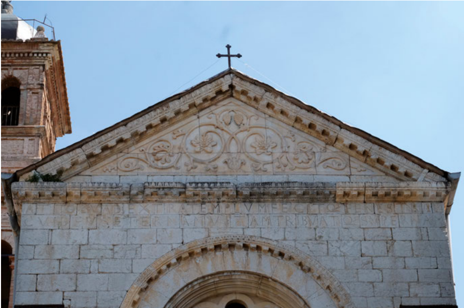
Abb. 16: Bovara, Abteikirche, Westfassade, Inschrift unter dem Giebelgesims.
