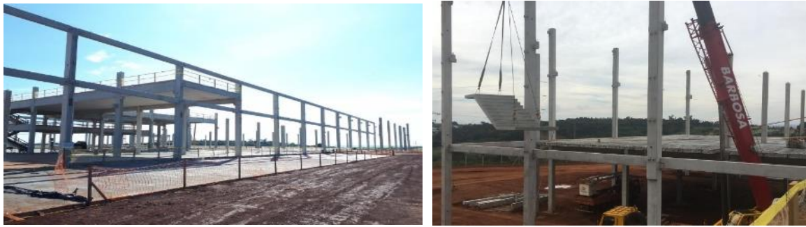
Figura 9: Início da montagem da estrutura pré-moldada
