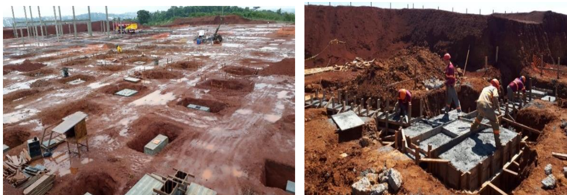
Figura 8: Execução de viga de equilíbrio para correção do projeto
