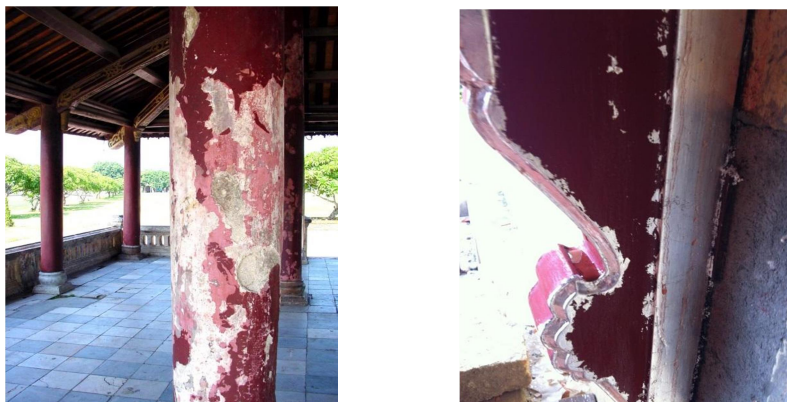
Hình 8. Cột trụ bằng xi măng Phú Văn Lâu, và đắp xi măng trên trụ cột Tử Cấm Thành, Ảnh tác giả
