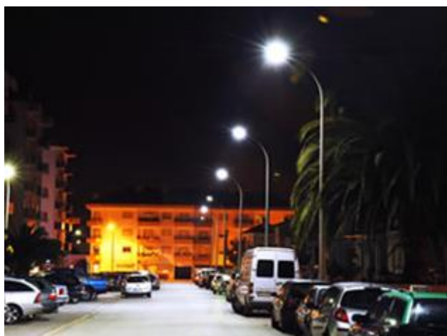
Figura 3.35 – Iluminação pública com LED em contraste com a iluminação tradicional 58
