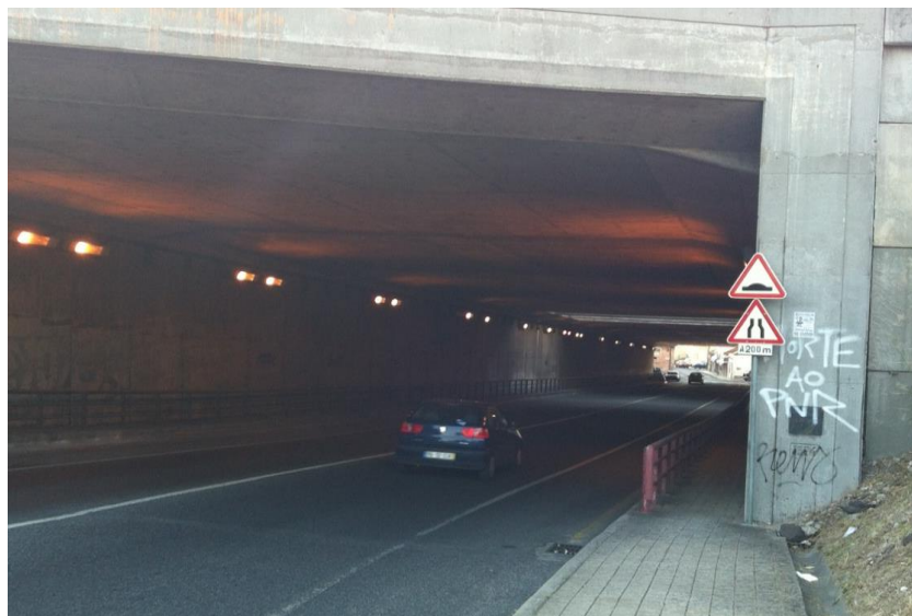
Figura 3.33 – Túnel da Buraca, 2013
