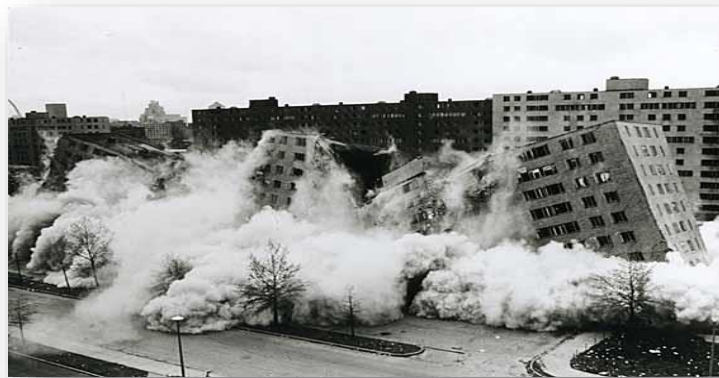
Figura 2.12 – A demolição do complexo habitacional Pruitt-Igoe, 1972
