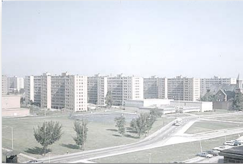
Figura 2.9 – Complexo habitacional Pruitt-Igoe na sua fase inicial.
