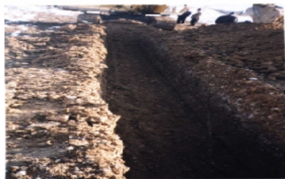
Fig. 7: Excavated conduit
