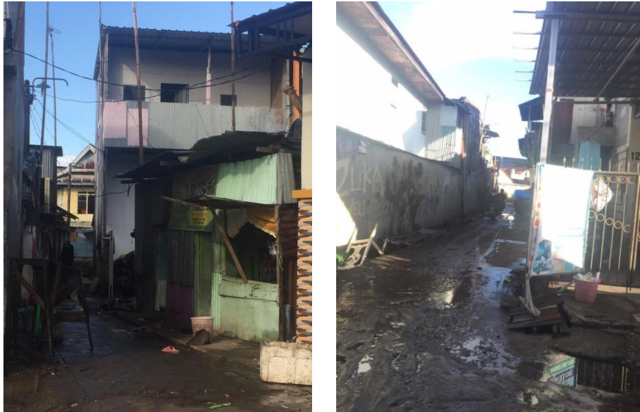
Gambar 2 Kondisi jalan lingkungan (Sumber: Hasil survey lapangan, Juni 2020)
