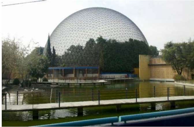
Figura 15. Detalle del aviario en el año 2011, antes de la intervención del gobierno en 2015.
