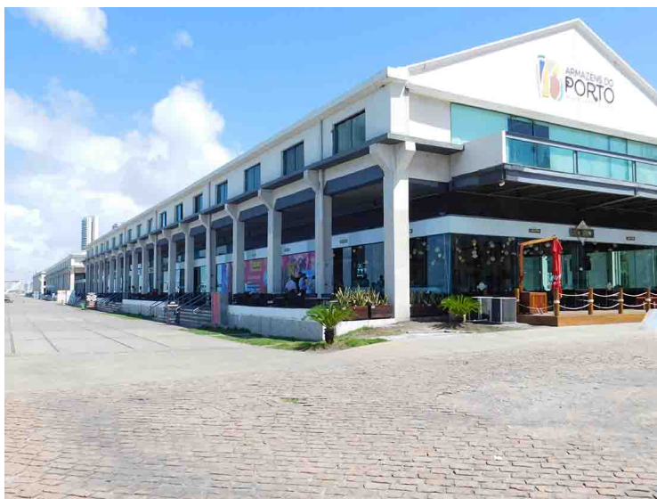
Figura 12 – Armazéns do Antigo Porto – 2019 Foto: Sandra Simone
