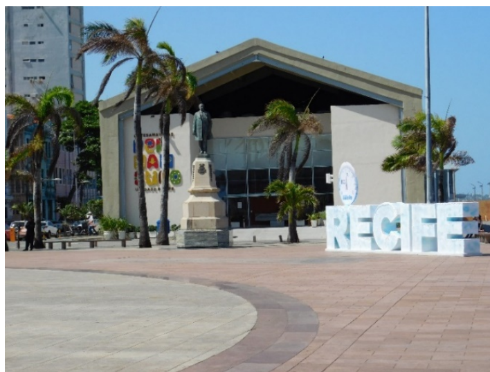
Figura 13 – Armazéns do Antigo Porto 2019 Foto: Sandra Simone
