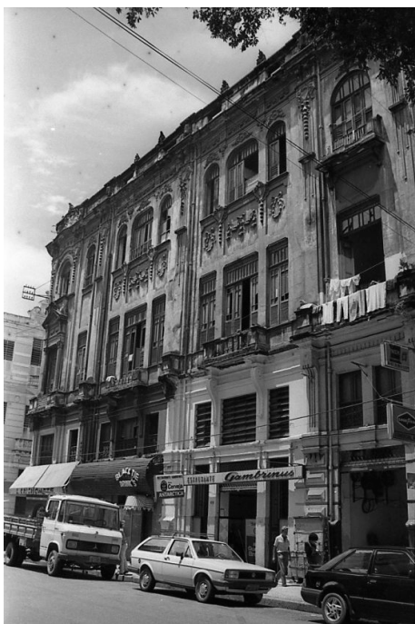
Figura 6 – Fachada dos casarios do Bairro do Recife e do Restaurante Grambrinus – 1987
