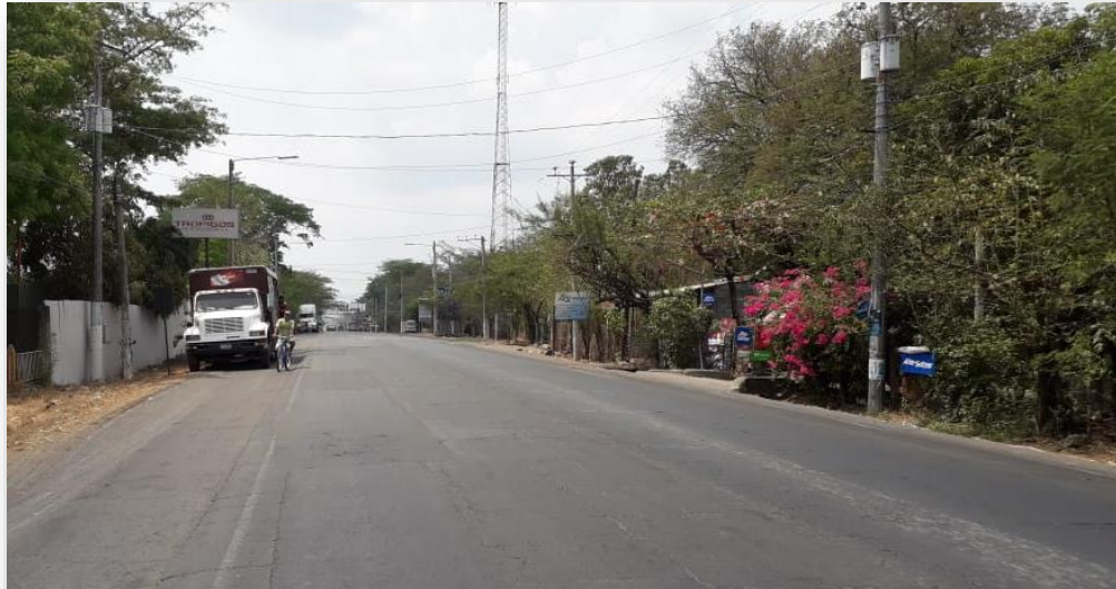
Imagen N° 3.1.2 Acceso al Terreno
