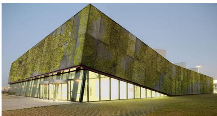
Imagen N° 4.12 estructura con hormigón biológico
