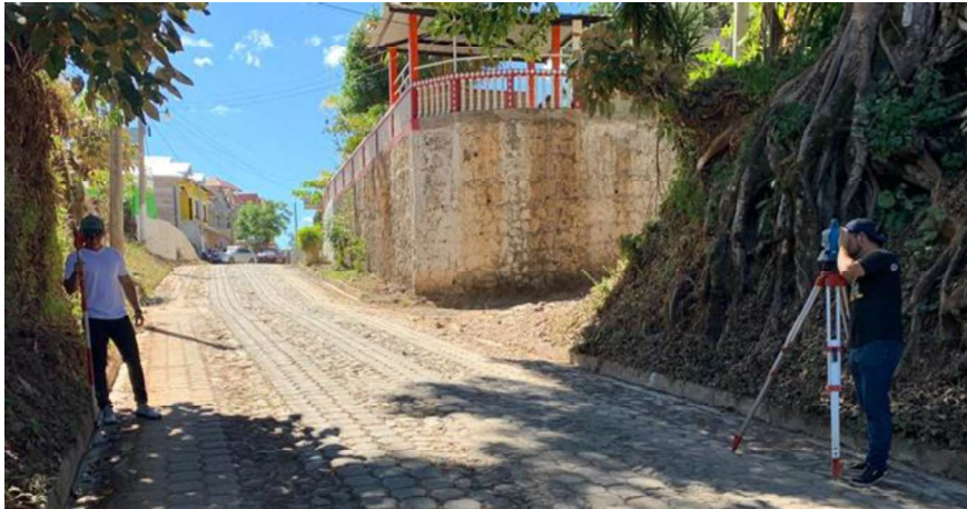
Imagen 42: Levantamiento topográfico en sector las Palmeras.
